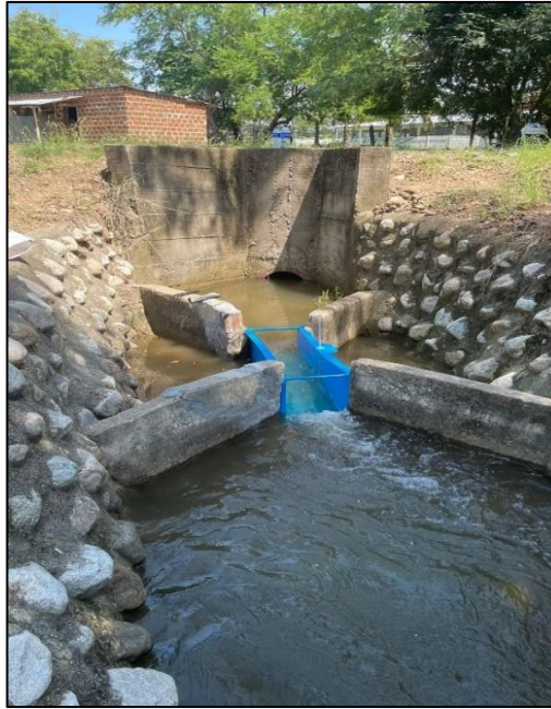
Figura 5. ADECUACIÓN DEL CANAL SECUNDARIO
