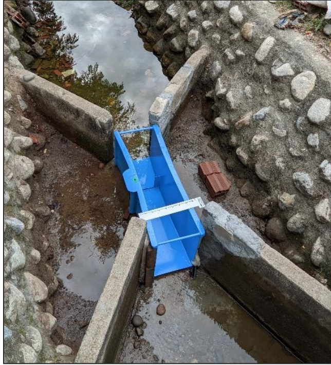
Figura 7. LIMPIEZA PREVENTIVA DEL CANAL SECUNDARIO
