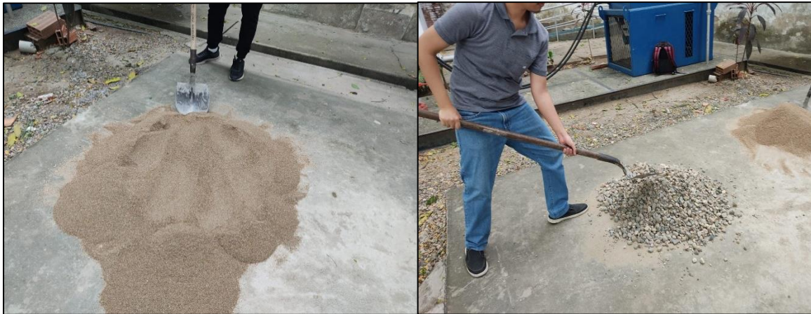
Figura 3-2: Apilamiento de bolsas, vaciado y mezclado de (a) agregado fino (arena) y (b) agregado grueso (grava).
