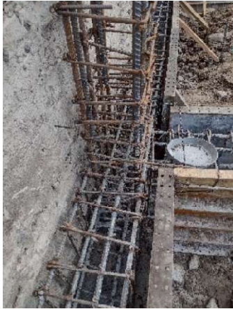
Fotografía 56. Detalle de aceros.
