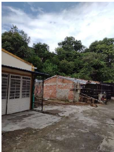
Fotografía 27. Limpieza de terreno.
