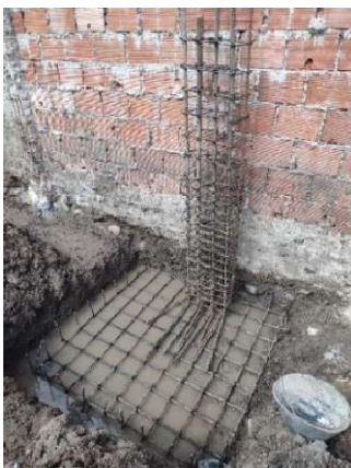
Fotografía 38. Instalación de aceros.
