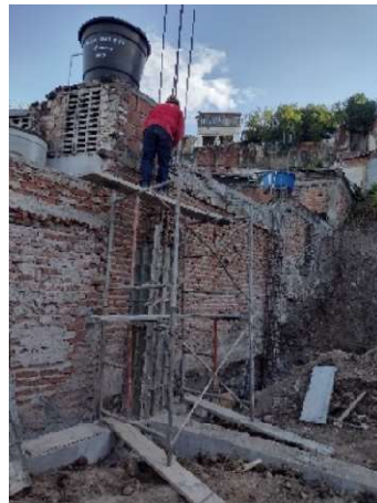
Fotografía 60. Instalación de formaleta.
