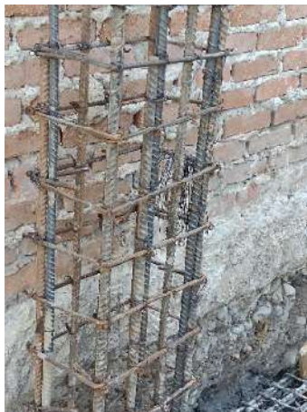
Fotografía 53. Instalación de aceros.
