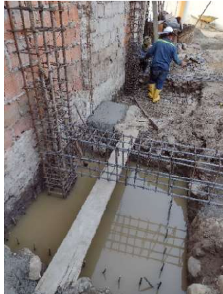
Fotografía 39. Instalación de aceros.
