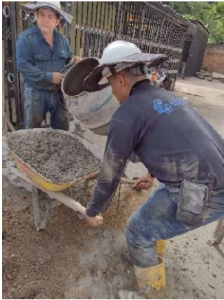
Fotografía 36. Preparación de mezcla para solado.
