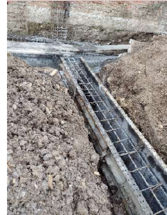
Fotografía 42. Instalación de aceros.
