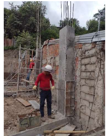
Fotografía 72. Retiro de formaleta.
