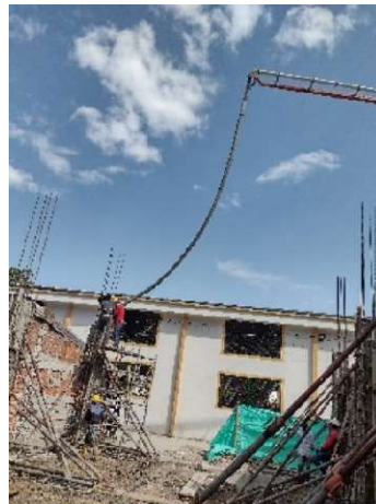
Fotografía 68. Vaciado de concreto.
