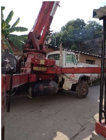
Fotografía 66. Concreto de planta.
