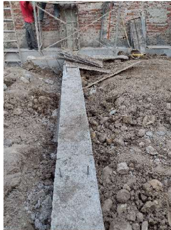
Fotografía 49. Vigas de cimentación.
