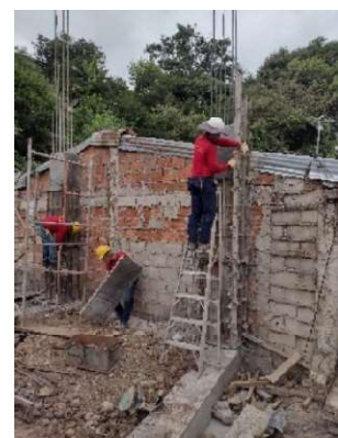
Fotografía 73. Retiro de formaleta.
