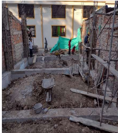
Fotografía 48. Vigas de cimentación.
