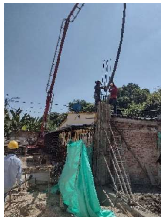
Fotografía 70. Vaciado de concreto.
