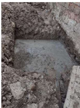
Fotografía 31. Solado de limpieza para zapata.
