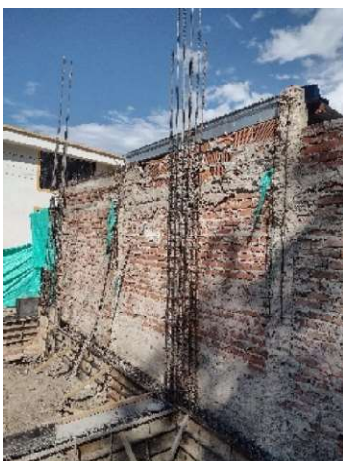
Fotografía 58. Instalación de aceros.
