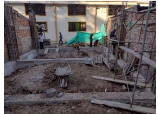
Fotografía 51. Vigas de cimentación.
