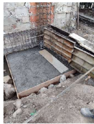
Fotografía 41. Fundición de zapata.
