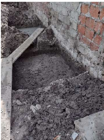
Fotografía 30. Excavación de zapatas.
