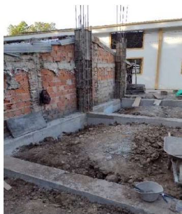
Fotografía 50. Vigas de cimentación.
