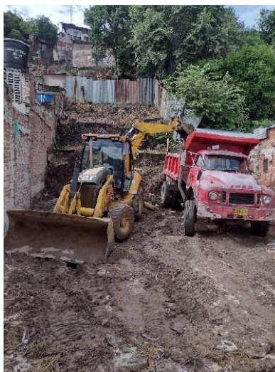
Fotografía 28. Retiro de material de excavación.
