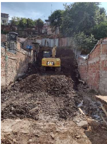
Fotografía 22. Nivelación de terreno.
