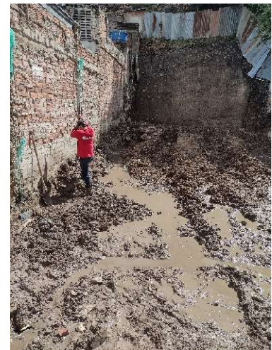
Fotografía 26. Nivelación de terreno.
