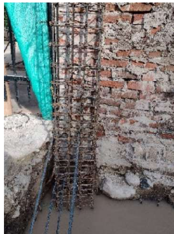
Fotografía 54. Detalle de aceros.
