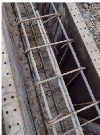
Fotografía 40. Detalle de aceros.
