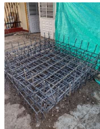
Fotografía 35. Acero para zapatas.
