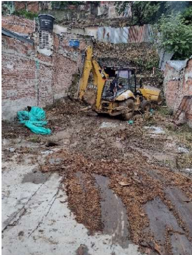
Fotografía 21. Descapote de terreno.
