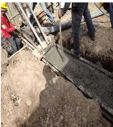
Fotografía 47. Vibrado del concreto.
