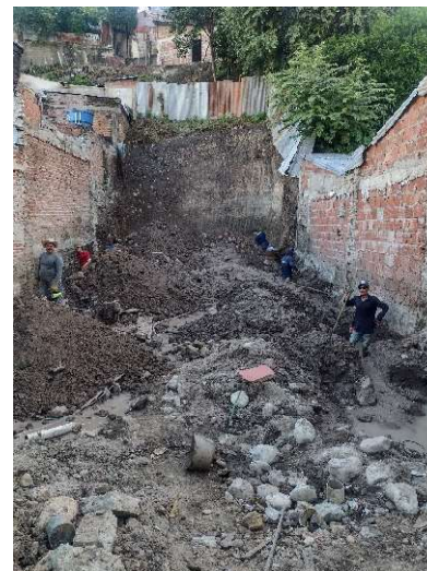
Fotografía 29. Nivelación de terreno.
