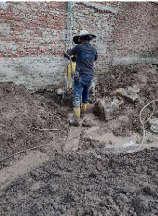
Fotografía 37. Vaciado de soldado de limpieza.
