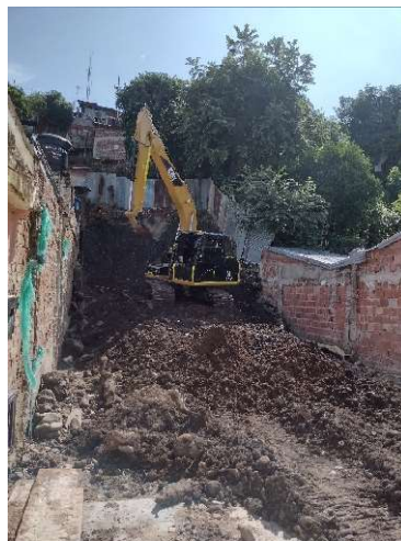
Fotografía 24. Nivelación de terreno.
