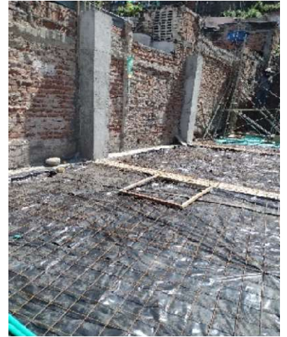
Fotografía 76. Columnas fundidas.
