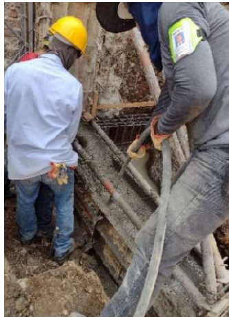
Fotografía 46. Vibrado del concreto.
