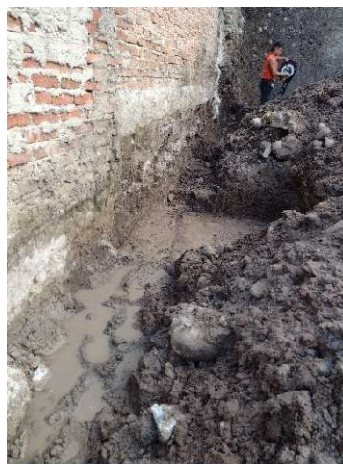
Fotografía 32. Excavación para vigas.
