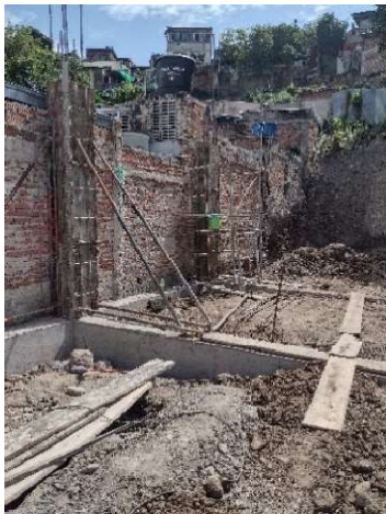
Fotografía 65. Instalación de formaleta.
