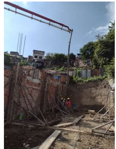
Fotografía 71. Vaciado de concreto.
