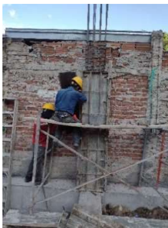
Fotografía 61. Instalación de formaleta.
