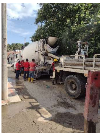
Fotografía 67. Concreto de planta.
