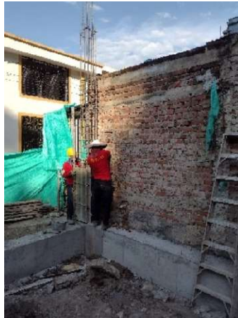
Fotografía 59. Instalación de formaleta.
