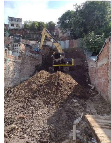
Fotografía 25. Excavación de terreno.
