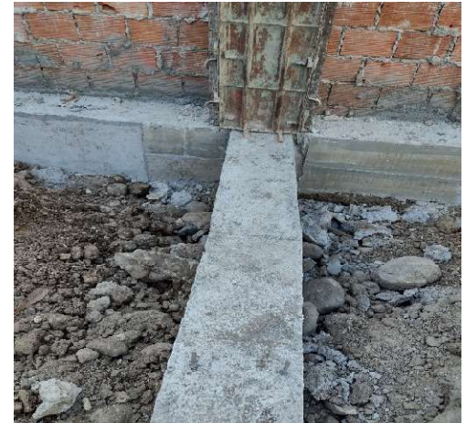
Fotografía 52. Viga de cimentación.
