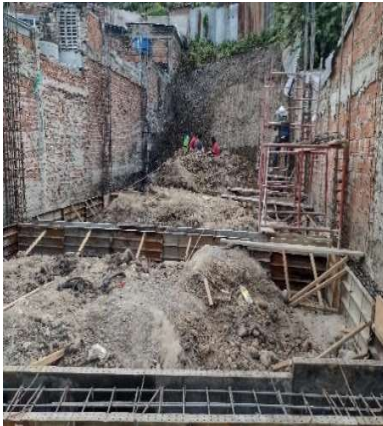
Fotografía 45. Instalación de formaleta.
