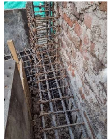
Fotografía 55. Detalle de aceros.
