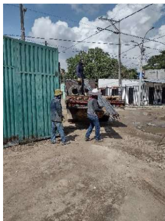
Fotografía 33. Descargue de acero de cimentación.
