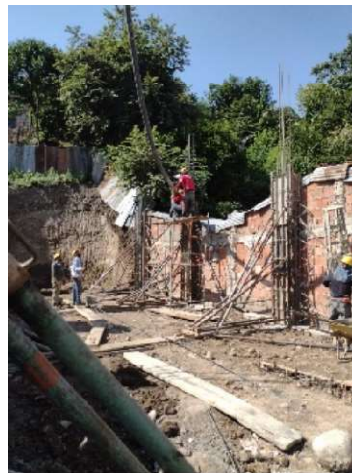
Fotografía 69. Vaciado de concreto.
