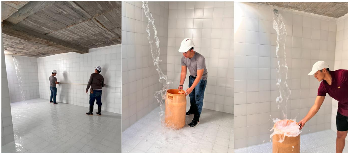
Figura 17 Medición de caudal entrante al tanque de almacenamiento.
