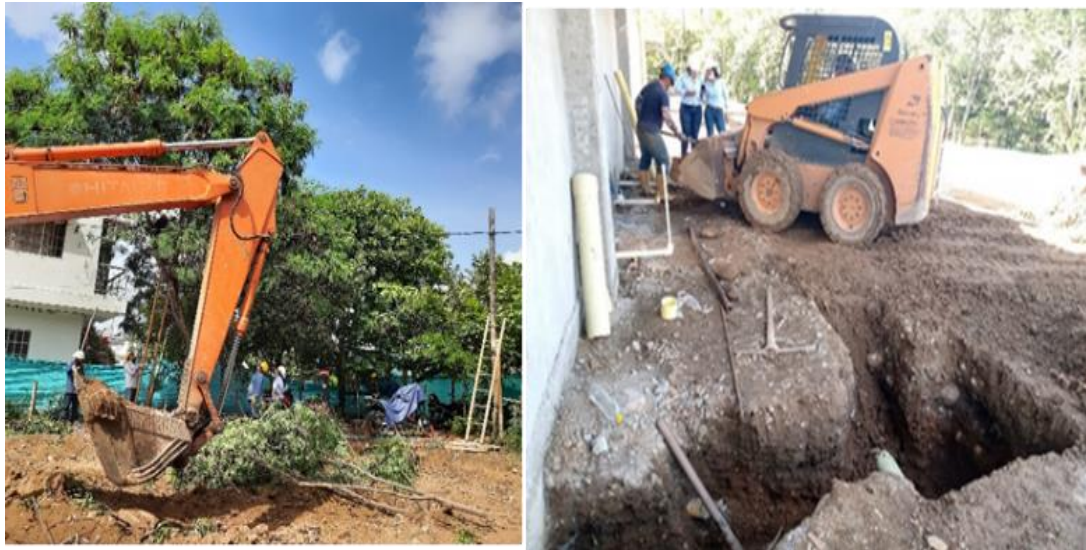
Figura 4-29. Generación de RCD a partir de remisión de tierra con material vegetal y de obra en proyecto multifamiliar en la ciudad de Neiva.
