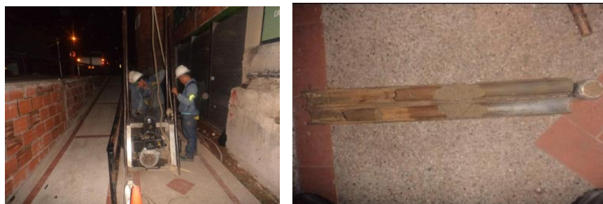
Figura 3-2: Registro fotográfico del ensayo geotécnico en el Centro Comercial. Fuente: Laboratorio Servi.Lab Ingeniería.
