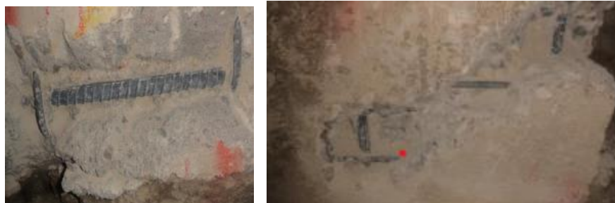
Figura 3-8: Registro fotográfico de regatas realizadas a viga de cimentación y pedestales del eje 16-H. Fuente: Servi.Lab Ingeniería.
