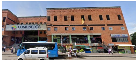
Figura 3-13: Fachada de Carrera 2. Fuente: Google maps.
