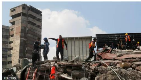
Figura 2-1: Estructuras colapsadas y no colapsadas después de un evento sísmico. Tomado de: (BBC Mundo, 2017)
