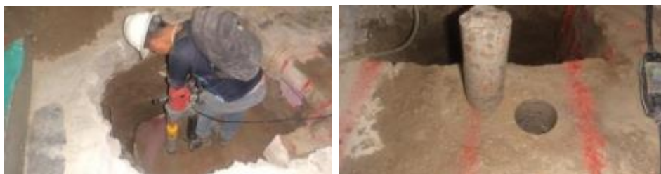
Figura 3-5: Registro fotográfico de extracción de núcleos a zapata del eje 16-H. Fuente: Servi.Lab Ingeniería.
