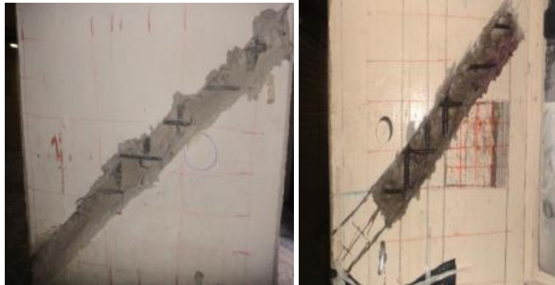
Figura 3-7: Registro fotográfico de regatas realizadas a Columnas eje 16-H y eje 18-H del piso 1. Fuente: Servi.Lab Ingeniería.
