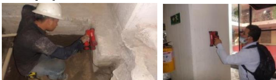
Figura 3-3: Registro fotográfico de detección de refuerzos a zapatas y columnas de primer piso. Fuente: Servi.Lab Ingeniería.
