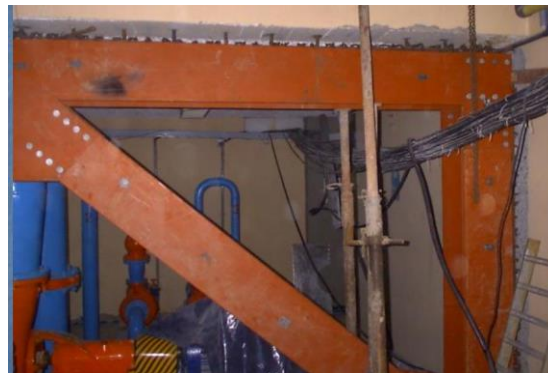
Figura 3-29. Conexión indirecta en estructura existente. Fuente: Garza (2022)
