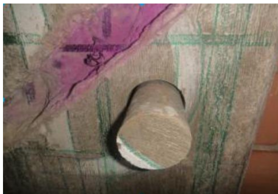
Figura 3-6: Registro fotográfico de extracción de núcleos a columna del eje 19-D. Fuente: Servi.Lab Ingeniería.
