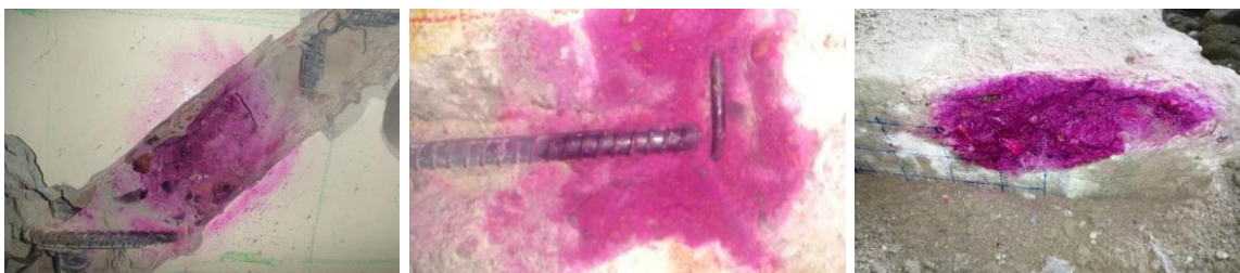
Figura 3-10: Registro fotográfico de regatas realizadas a vigas de cimentación y pedestales. Fuente: Servi.Lab Ingeniería.
