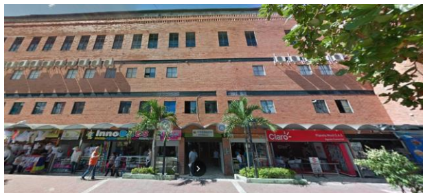
Figura 3-16: Fachada de Carrera 1H. Fuente: Google maps.
