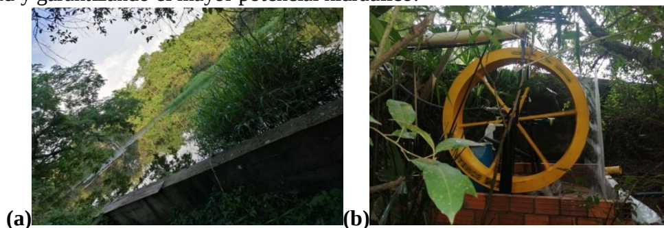
Figura 13. (a) Presa de almacenamiento, (b) Montaje del conjunto de la Bomba ZM 95 MAXXI
