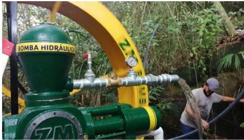
Figura 16. Puesta de accesorios de la tubería de descarga
