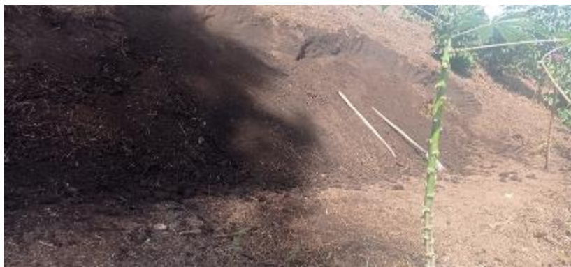
Imagen 4. Preparación de terreno.
