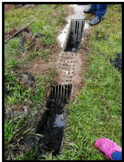
Figura 14. Rejilla gruesa y rejilla fina Figura 15. Rejilla fina en malas condiciones
