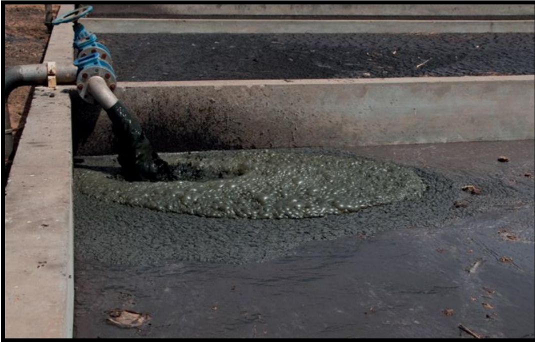
Pierre,H. y Ronteltap M. 2012 Lechos de Secado sin Plantas ( Figura 8 ). Ejemplo de carga de lodos sobre los lechos de secado
