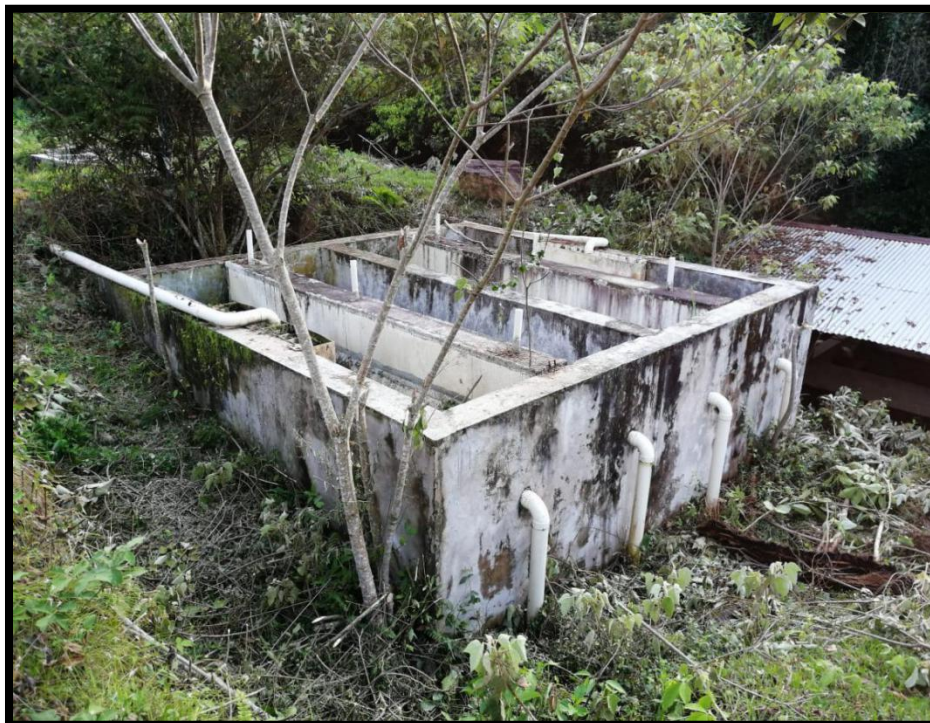
Figura 19. Reactor UASB sin tratamiento de gases
