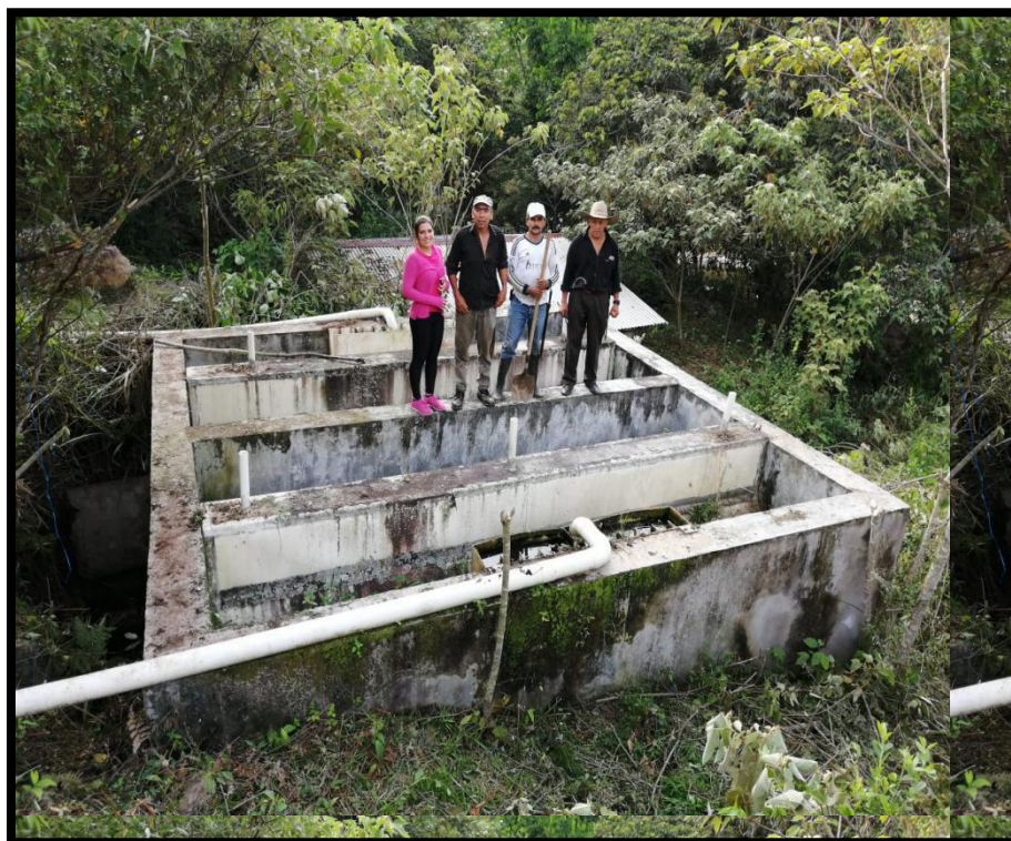
Figura 19. Reactor UASB sin tratamiento de gases
