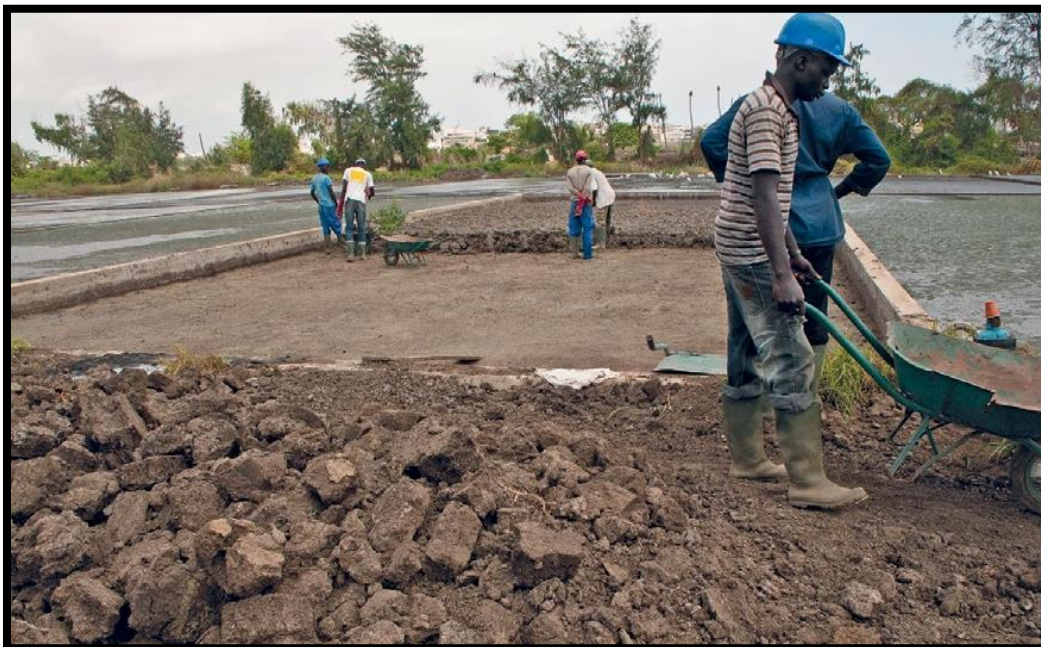
Pierre,H. y Ronteltap M. 2012 Lechos de Secado sin Plantas ( Figura 9 ). Ejemplo de extracción de lodos de los lechos de secado
