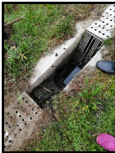
Figura 14. Rejilla gruesa y rejilla fina Figura 15. Rejilla fina en malas condiciones
