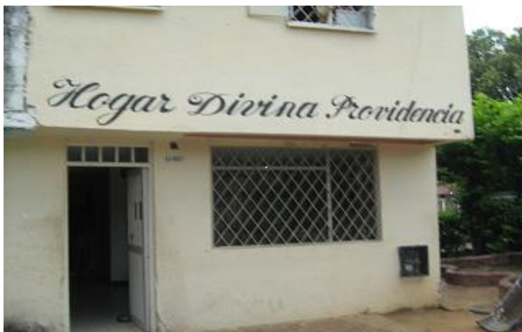
Fachada de la casa donde funciona el hogar.
