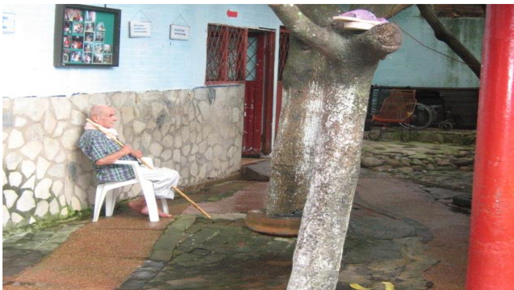
Patio, zona de esparcimiento para la comunidad (en la imagen se puede notar la inadecuación del lugar).
