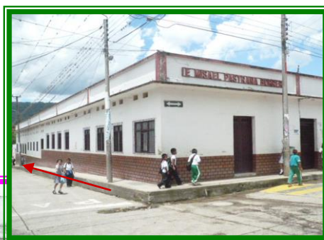
FOTO 2. Panorama Perfil del centro educativo Misael Pastrana Borrero sobre la calle 3 con carrera 4 esquina.
