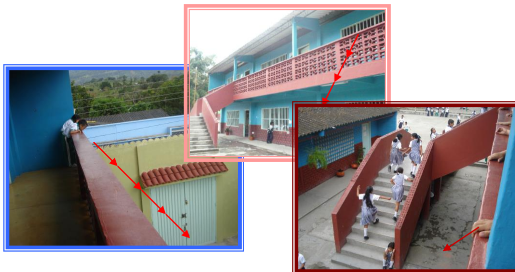
FOTO 17. Imagen del segundo piso del plantel.
