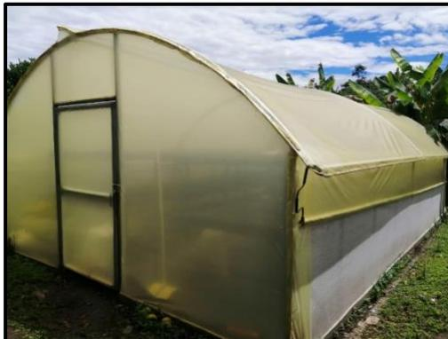
*Figura 1. Secador solar tipo marquesina de dos niveles
