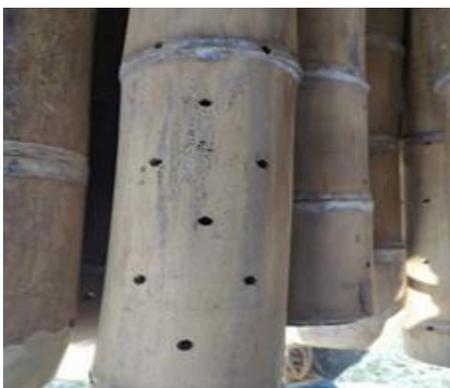
*Figura 24. Modelo de perforación B. Fuente: Autores*
