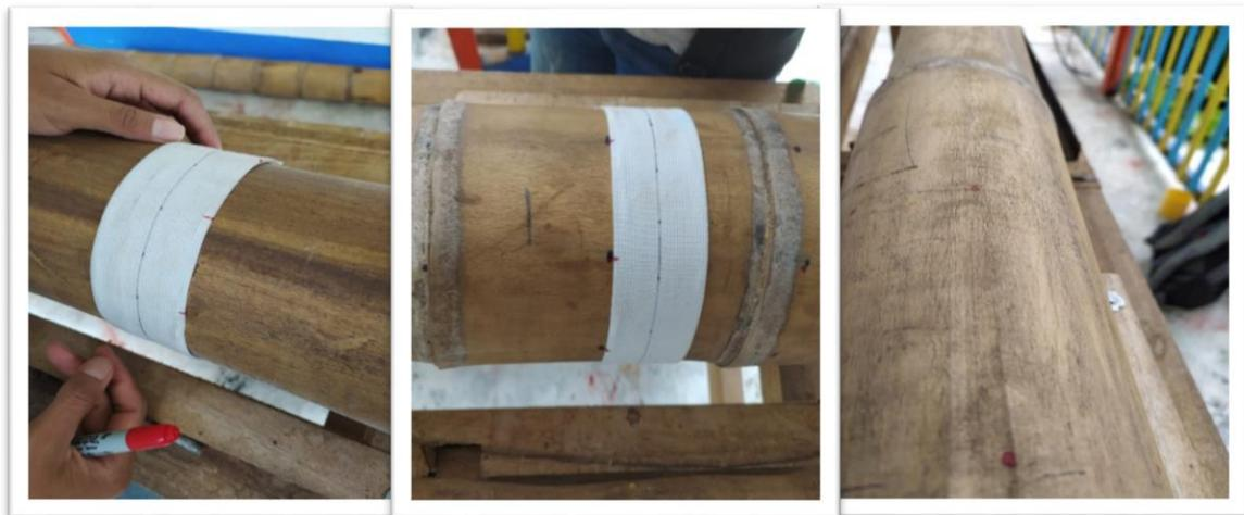
*Figura 6. Utilización banda elástica para marcación perimetral. Fuente: Autores.*
