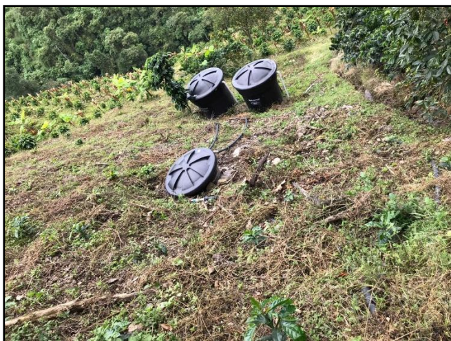
Figura 18. Recamara Dosificadora y Reactores Metanogénicos.
