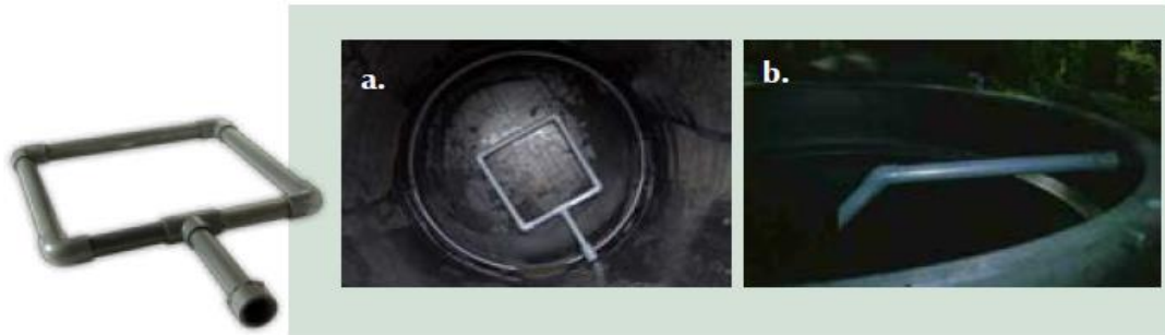
Figura 5. a. Dispositivo distribuidor de entrada de aguas residuales al reactor metanogénico, b. tubería de salida del efluente.
