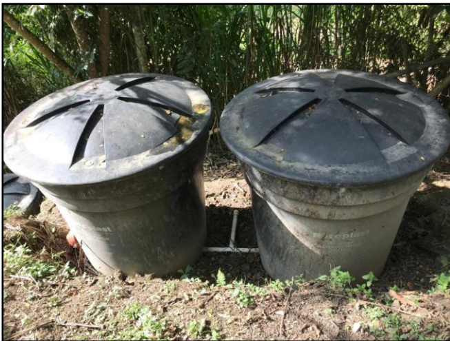
Figura 16. Reactores Hidrolíticos Acidogénicos.
