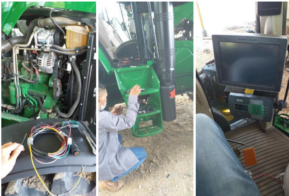
Instalación de equipos de control de flota Auteq 3200 en tractor 6175M
