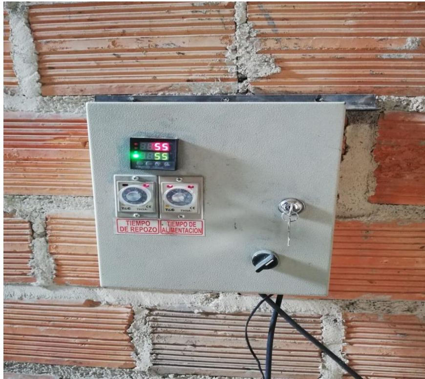
Figura 24. Panel de control para la Temperatura de operación
