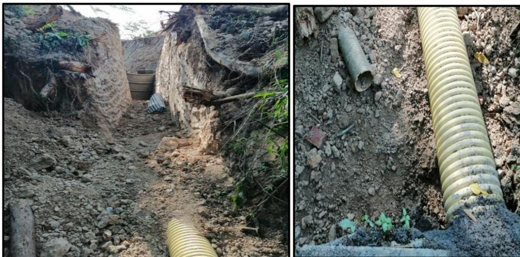
**Figura 16.** Cambio de tubería.
