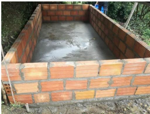
*Figura 27. Tanque para filtro preliminar.*
