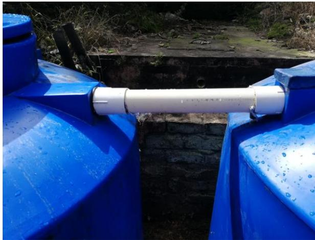
*Figura 33. Conexión de filtros anaerobios con guadua 1 y 2.*
