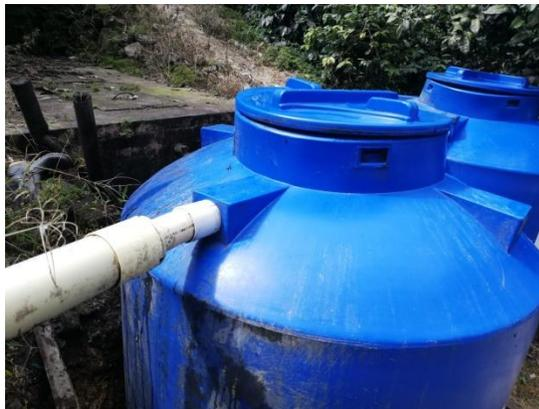
*Figura 31. Conexión de filtro de cascarilla con filtro anaerobio 1.*
