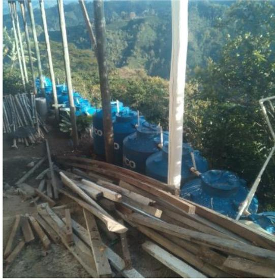
*Figura 11. Sistema de tratamiento de aguas residuales de café implementado en la finca La Suiza, 8 hectáreas.*
