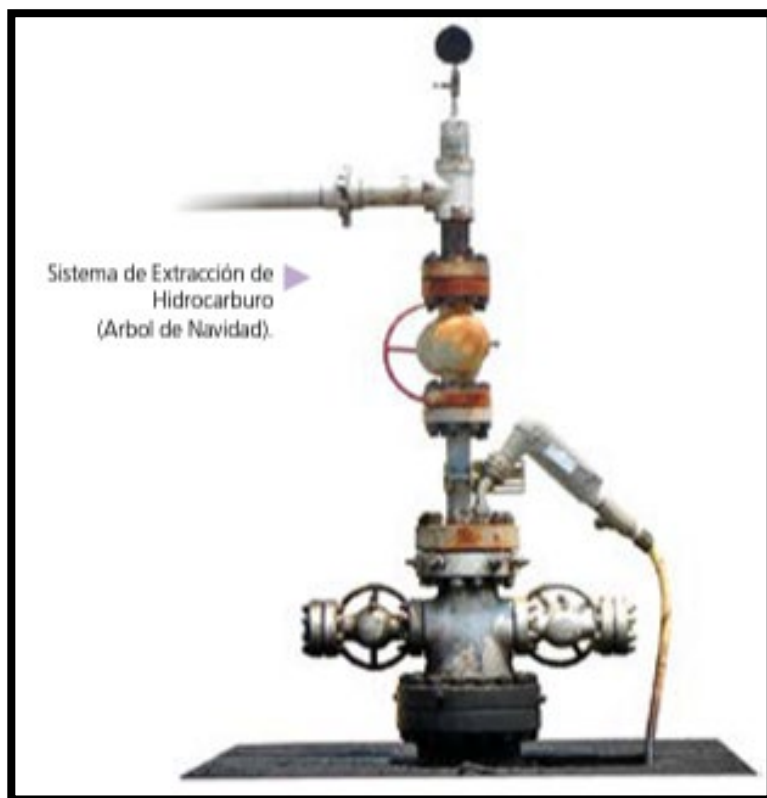
Figura 1. Cabezal de pozo de producción petrolera (Árbol de navidad) Fuente: PDVSA, 2000
