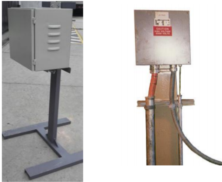
Figura 4. Cajas de venteo.
