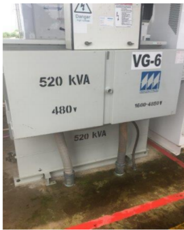
Figura 2. Transformador reductor y Transformador elevador FUENTE: ESP OIL ENGINEERING CONSULTANTS, 2004
