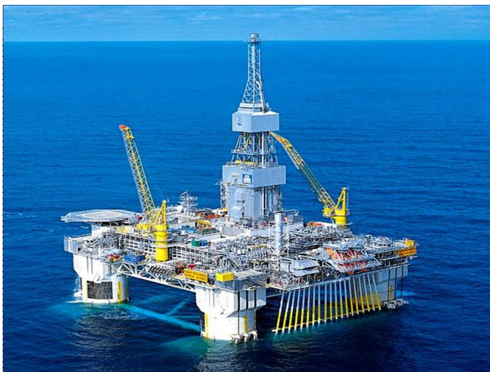
Figura 16. Plataforma semi-sumergible (Pérez & Gonzáles, 2014, p.9).
