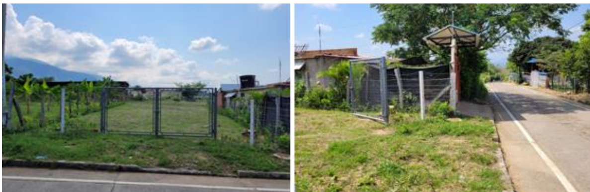
Imagen 1. Vía de acceso e ingreso al terreno del proyecto.
