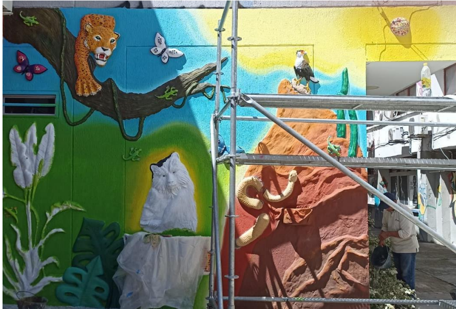
Instalación de piezas escultóricas
