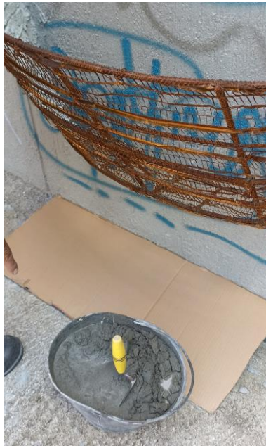
Anclaje de estructura en hierro – Matera
