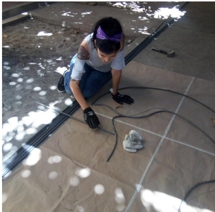
Doblado de Varilla – Escultura con estructura de hierro y hormigón
