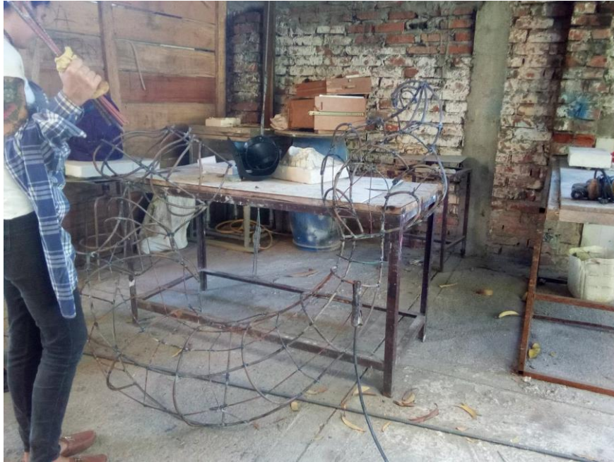
Soldada de estructura de hierro – Sirena
