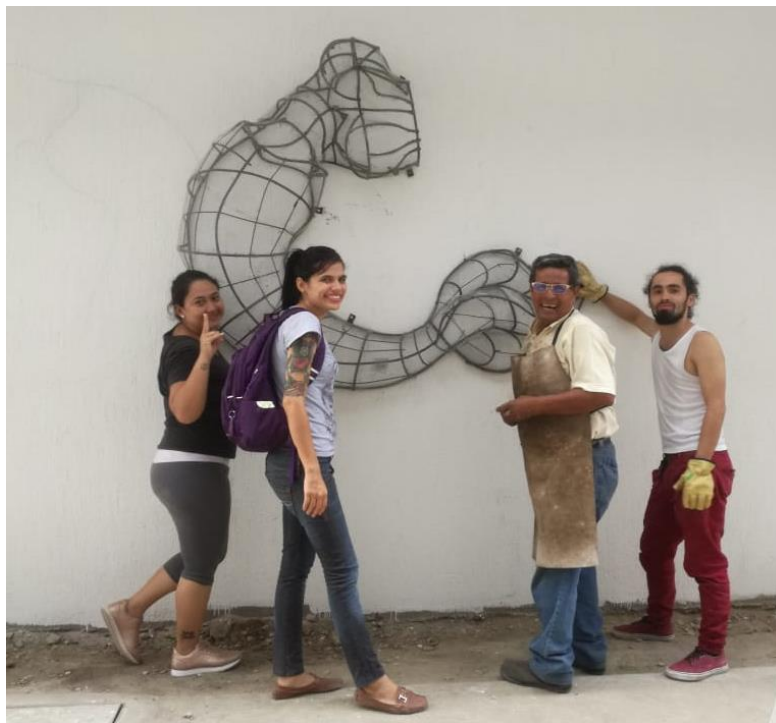
Anclaje de estructura en hierro – Sirena
