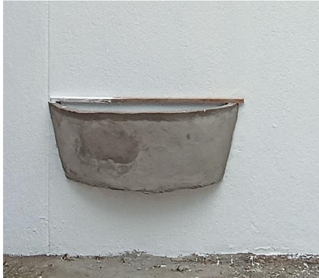
Estructura de hierro con hormigón – Matera
