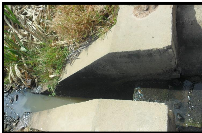
Figura 15 Salto Hidráulicos Con Desviación Lateral (Vasquez A & Carvajal A, 2018)
