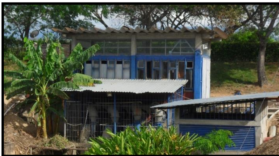
Figura 21 Casa de Bombas Zona de Rebombeo (Vasquez A & Carvajal A, 2018)
