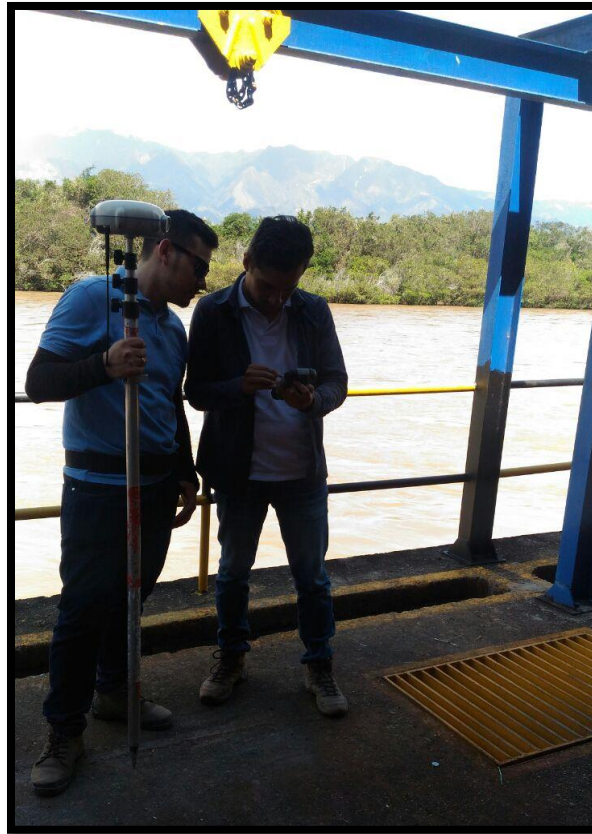
Figura 7 Toma de Datos de Las Obras Hidráulicas del DAT (Vasquez A & Carvajal A, 2018)
