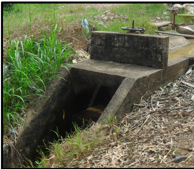
Figura 26 Saltos Hidráulicos con Compuerta Lateral (Vasquez A & Carvajal A, 2018)
