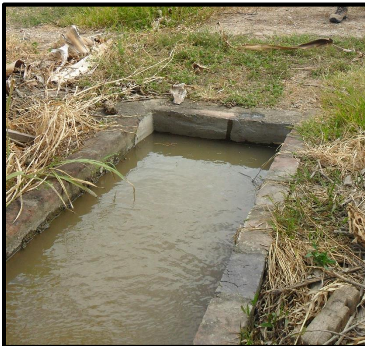
Figura 27 Viaducto Entrada (Vasquez A & Carvajal A, 2018)
