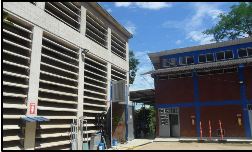
Figura 33 Casa de Bombas Zona de Bombeo (Vasquez A & Carvajal A, 2018)
