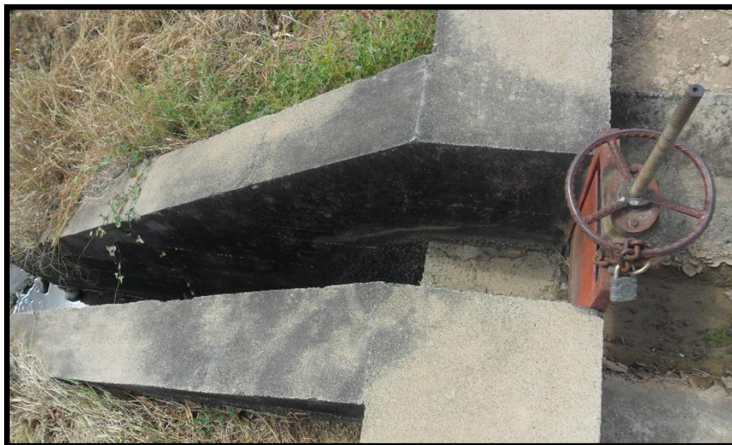
Figura 10 Compuertas con Salto Hidráulico (Vasquez A & Carvajal A, 2018)
