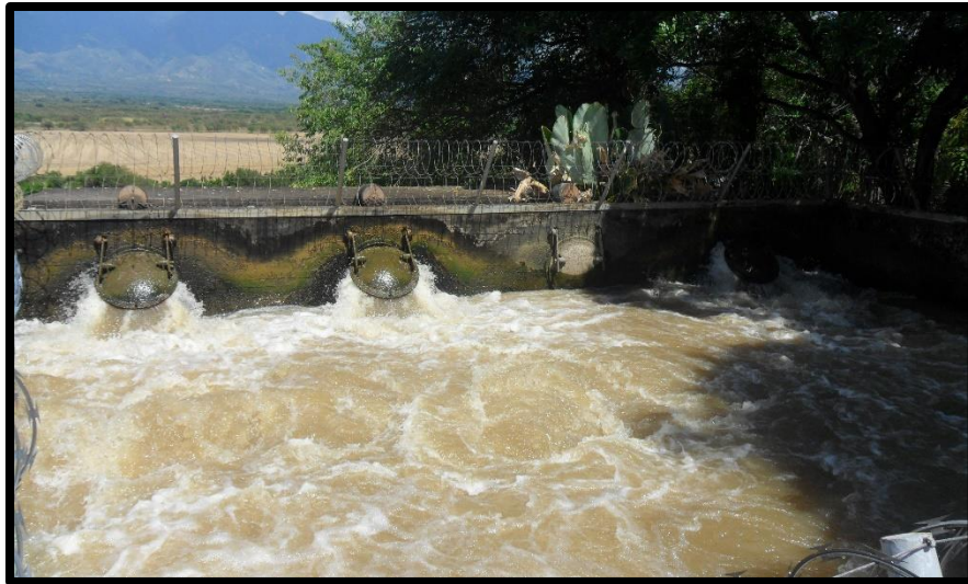
Figura 34 Descarga de Bombas Zona de Bombeo (Vasquez A & Carvajal A, 2018)
