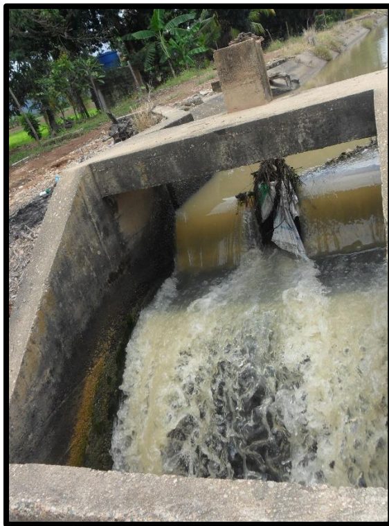
Figura 25 Saltos Hidráulicos Con Compuerta Central (Vasquez A & Carvajal A, 2018)
