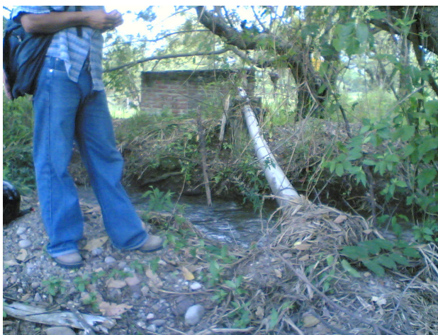
Figura 19. Instalación de la Tubería Principal.
