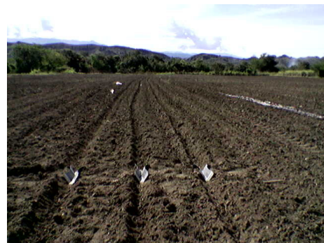
Figura 3. Instalación de las Canaletas
