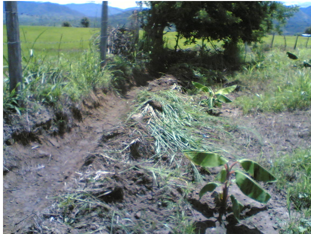
Figura 16. Construcción de las acequias principales de riego.
