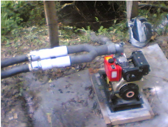
Figura 11. a) Instalación unidad de bombeo
