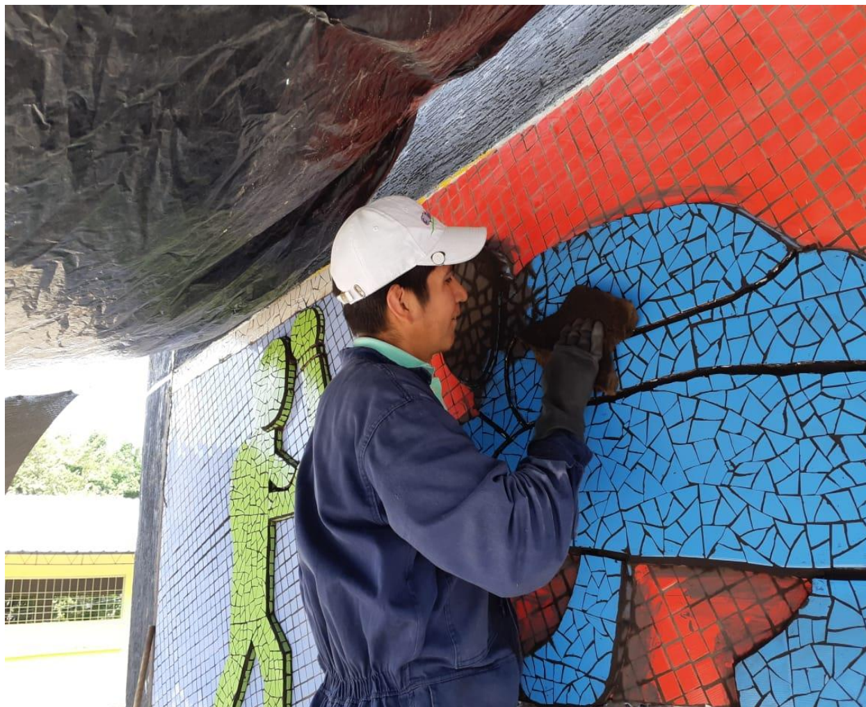
Fotografía 187 Emboquillado y limpieza de las figuras lado derecho izquierdo y centro del mural (limpieza de figura de violencia de cuerpo)
