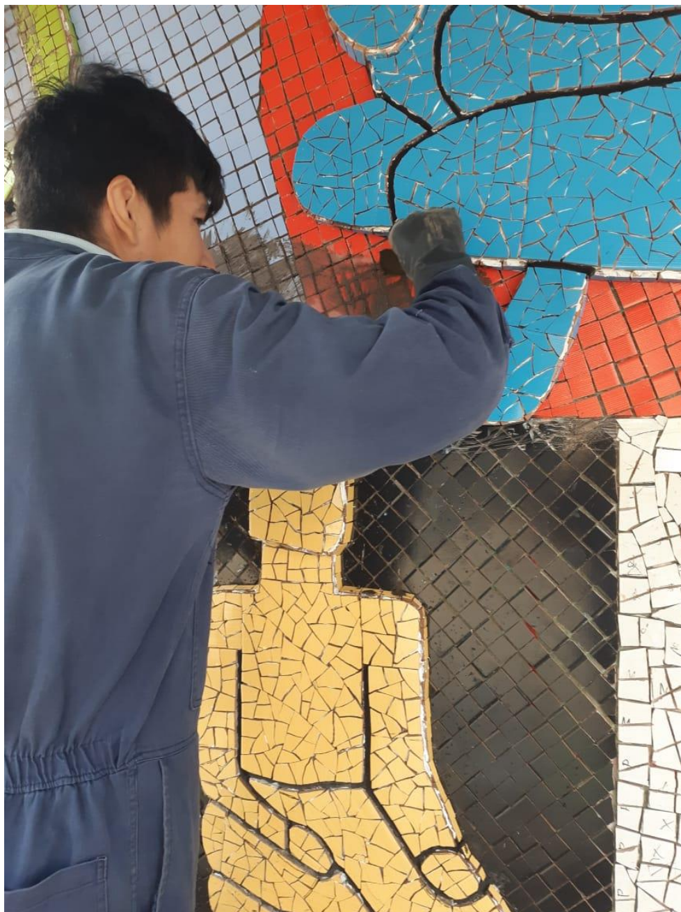
Fotografía 160 Metida de la boquilla con espátula plástica en medio de las ranuras entre la baldosa
