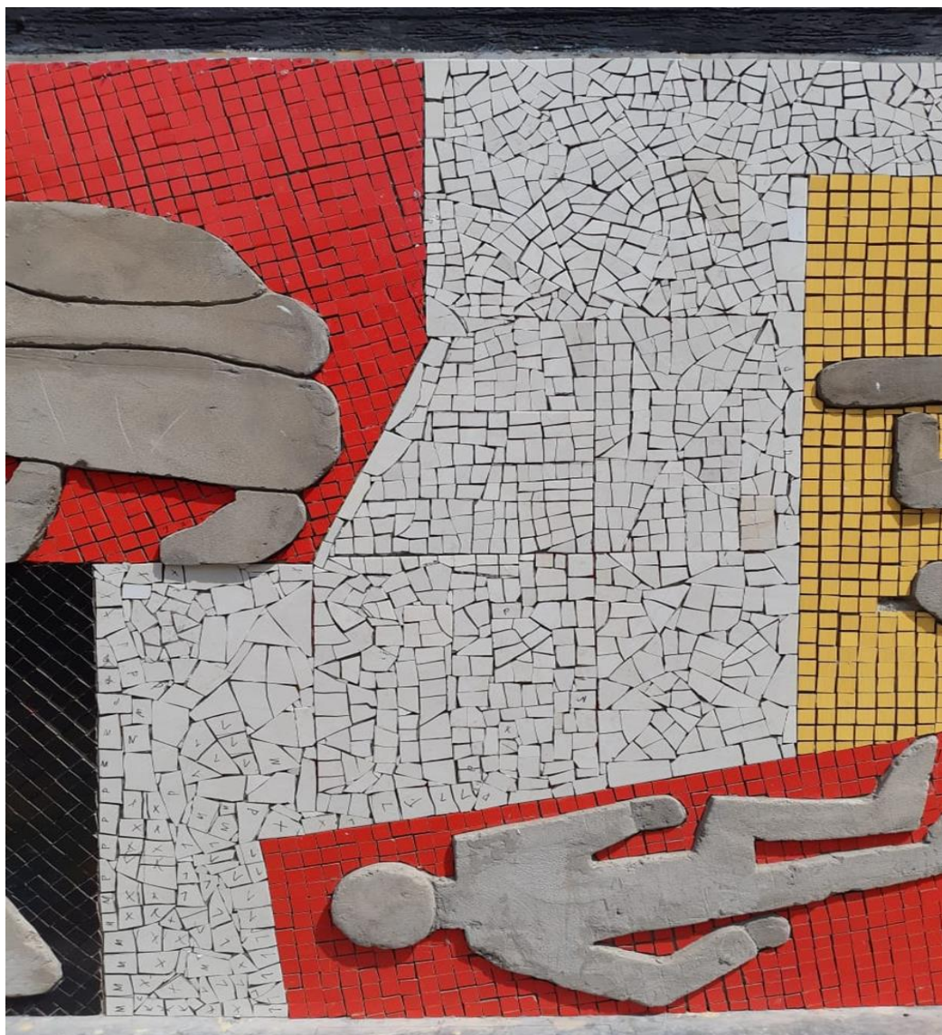
Fotografía 100 Plano general del lado izquierdo del centro ya terminado en mosaico beis
