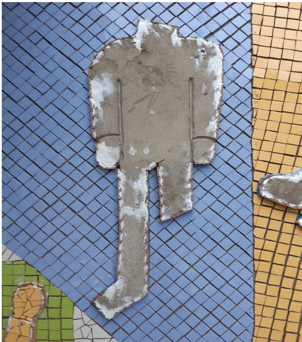
Fotografía 142 Figura del lado derecho parte de arriba ya terminada con su contorno externo en mosaico simétrico se hicieron los cortonos de todas las figuras del mural primero
