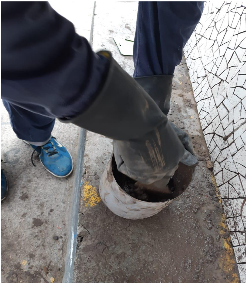
Fotografía 159 Preparación de la boquilla negra se revuelven los materiales con agua cemento y mineral negro
