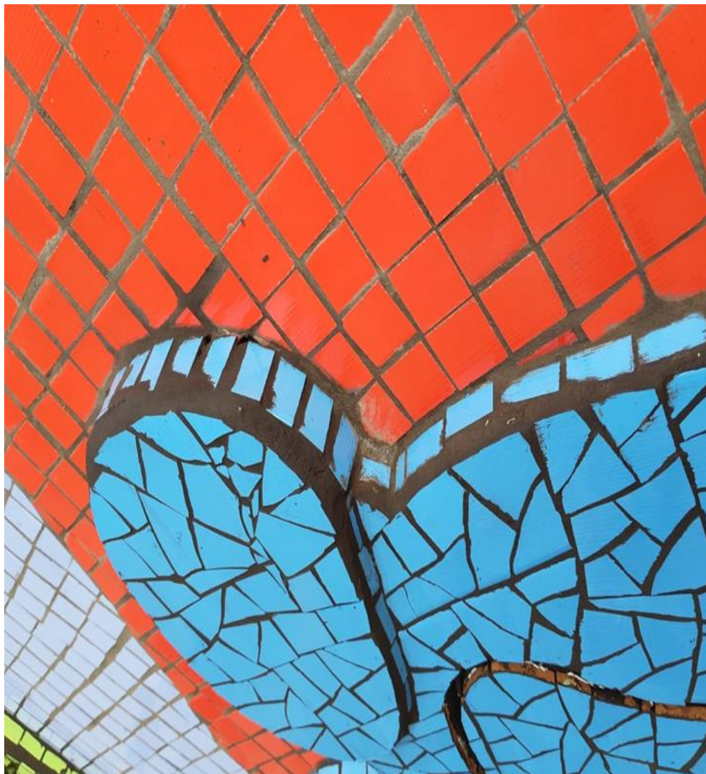
Fotografía 190 Emboquillado y limpieza de una las figura (violencia cuerpo) del lado izquierdo parte de arriba ya emboquillada contorno exterior de la cabeza parte de arriba
