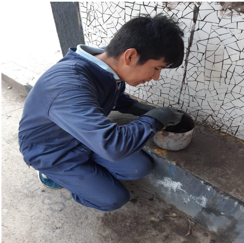
Fotografía 157 Mezcla del cemento arena y mineral negra para la boquilla negra
