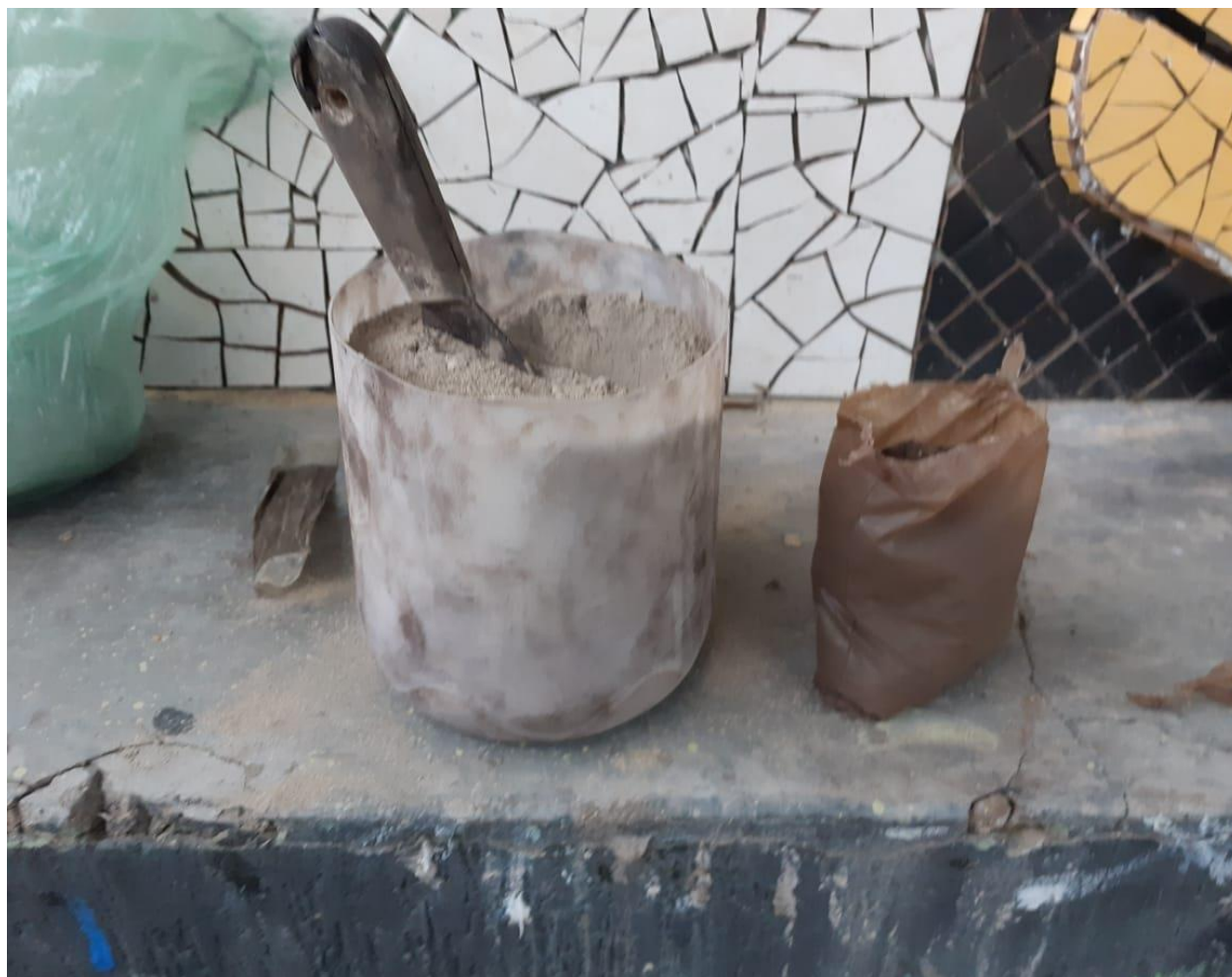
Fotografía 158 Mezcla de cemento gris y arena fina ya lista para mezclarse con el mineral negro
