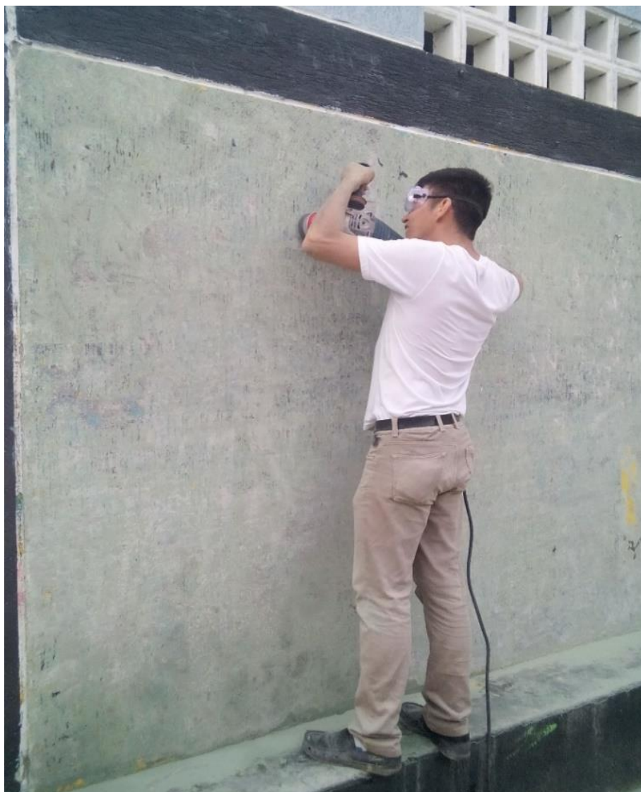
Fotografía 6 Limpieza de la pared con pulidora con grata y roto martillo con punta de cincel
