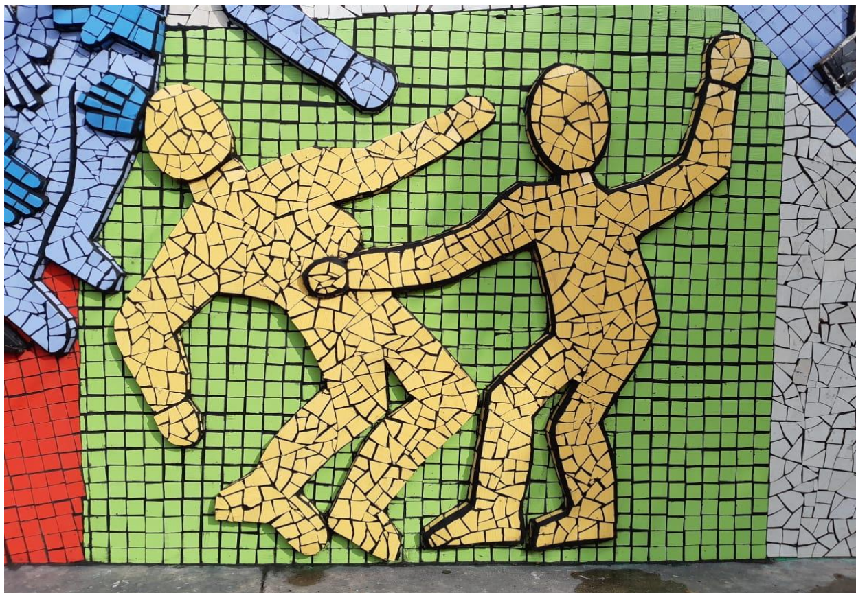
Fotografía 205 Emboquillado y limpieza de una las figura (violencia de pareja) del lado izquierdo parte de abajo ya emboquillada
