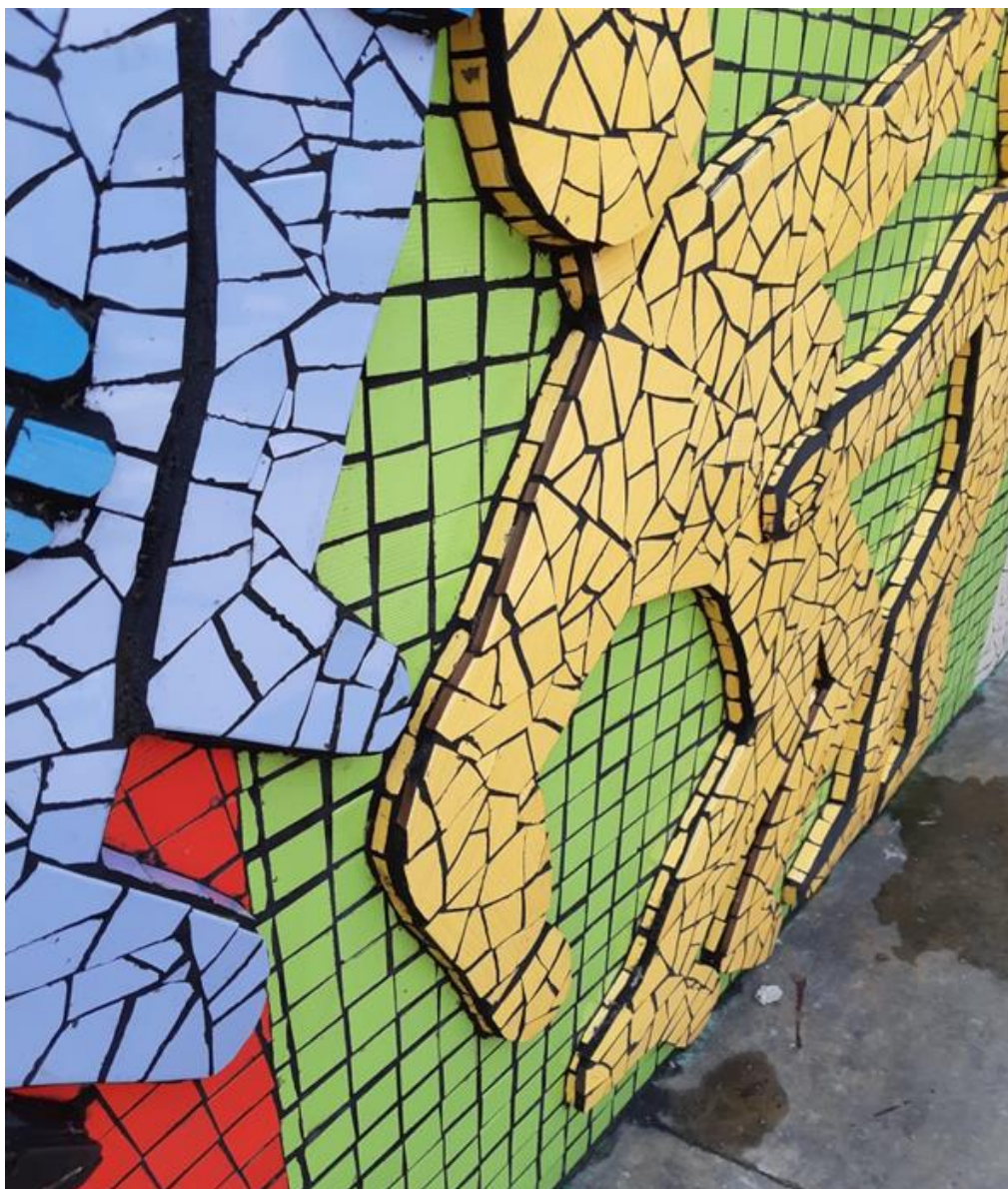
Fotografía 208 Emboquillado y limpieza de una las figura (violencia religiosa) centro parte de abajo ya emboquillada contorno exterior lado izquierdo
