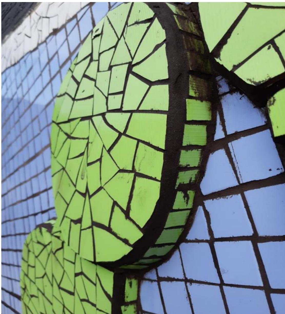
Fotografía 198 Emboquillado y limpieza de una las figura (violencia educativa) del lado izquierdo parte de arriba ya emboquillada contorno exterior cabeza lado derecho
