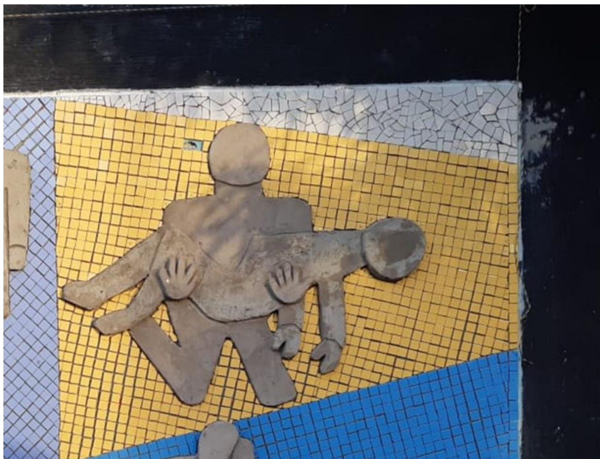
Fotografía 113 Pegado de mosaico beis del lado derecho parte de arriba ya terminado
