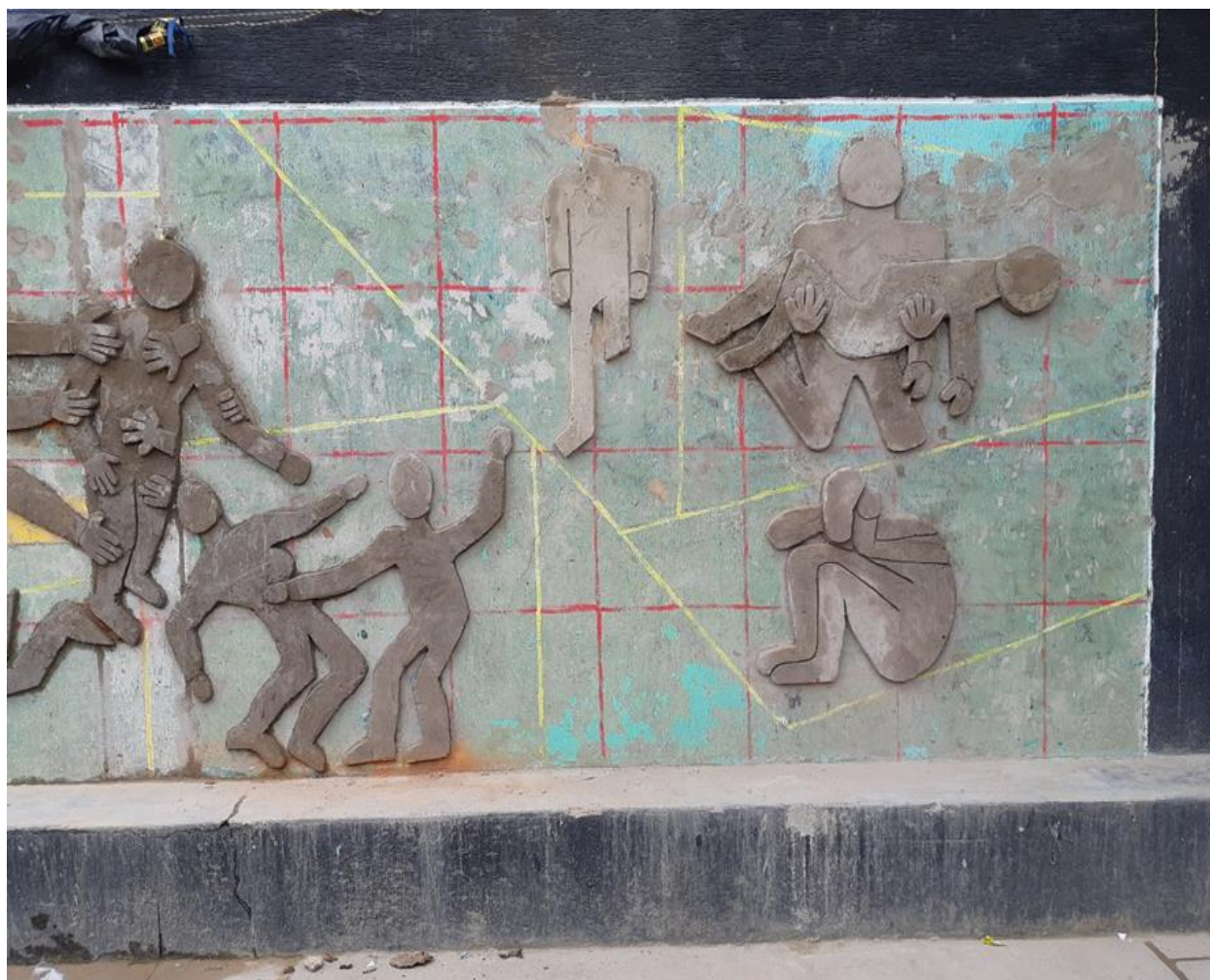
Fotografía 55 Figuras del lado derecho ya terminadas en pañete
