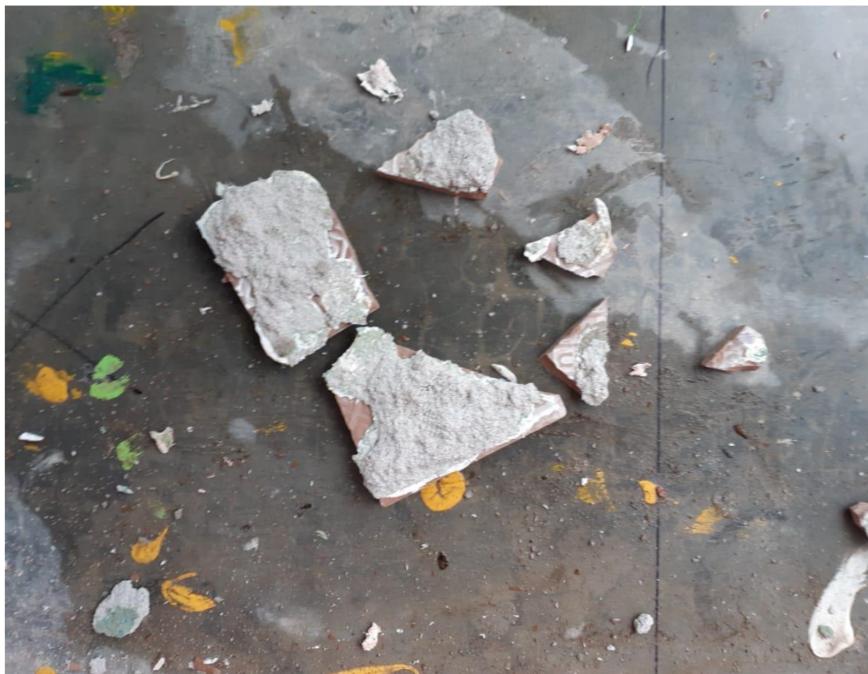
Fotografía 121 Partes mosaico asimétrico del lado izquierdo retirado al tratar de despegarlo para la corrección
