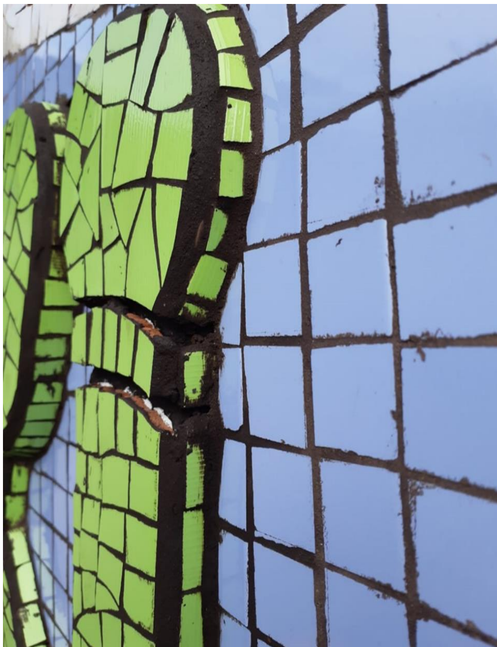
Fotografía 199 Emboquillado y limpieza de una las figura (violencia educativa) del lado izquierdo parte de arriba ya emboquillada contorno exterior cabeza del lápiz
