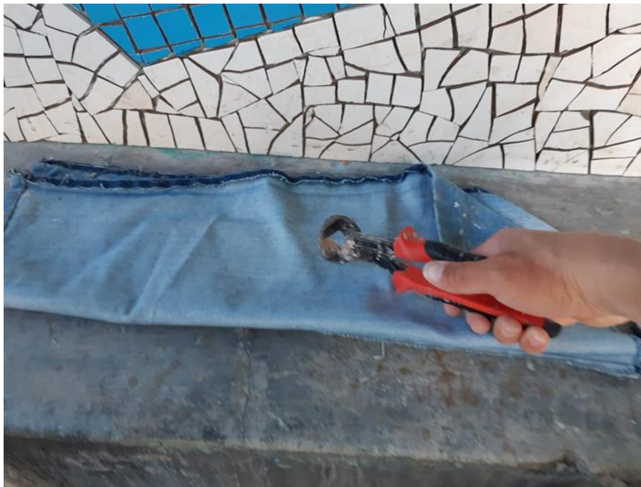
Fotografía 92 Tenazas y tela jean para la elaboración de teselas asimétricas para los fondos beis del mural
