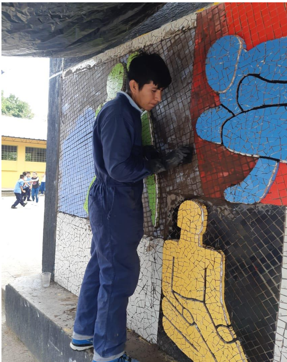
Fotografía 161 Limpieza de la boquilla de las figuras de arriba del lado izquierdo con espuma después de unos minutos aplicada la boquilla
