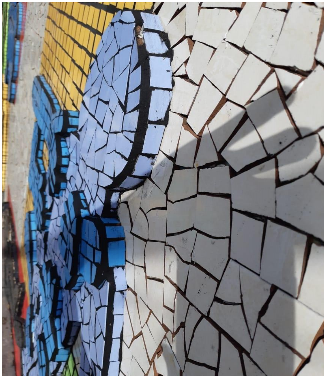
Fotografía 213 Emboquillado y limpieza de una las figura (violencia sexual ) centro parte de abajo ya emboquillada contorno exterior lado derecho de la cabeza
