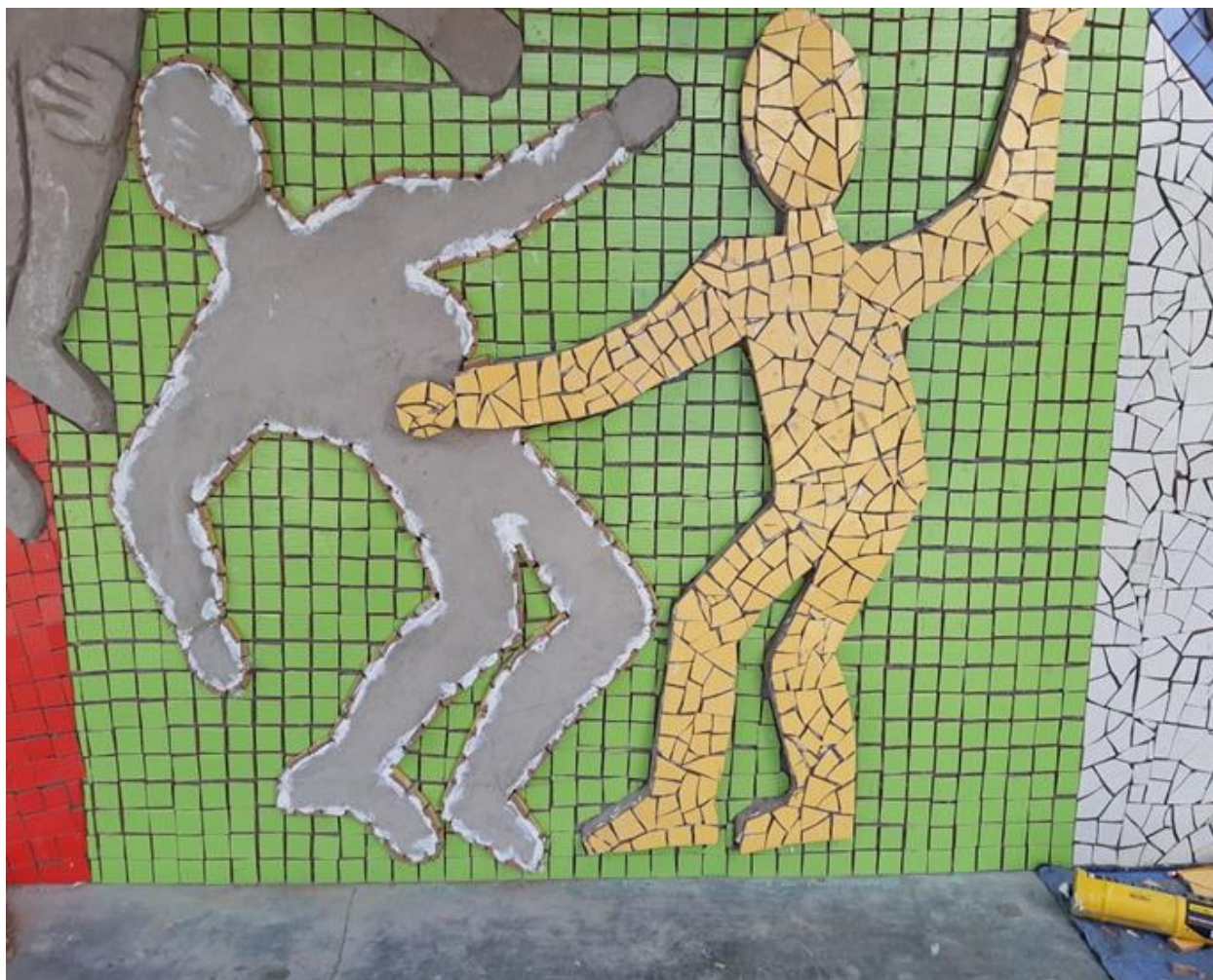
Fotografía 124 Una de las figuras del lado derecho de abajo ya terminada en mosaico asimétrico y la otra con el contorno externo terminado en mosaico
