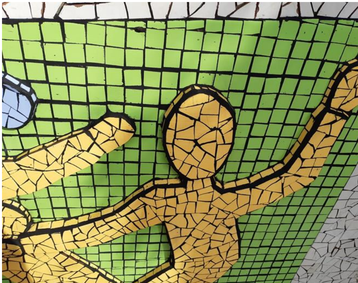
Fotografía 207 Emboquillado y limpieza de una las figura (violencia religiosa ) centro parte de abajo ya emboquillada contorno exterior parte de arriba figura derecha
