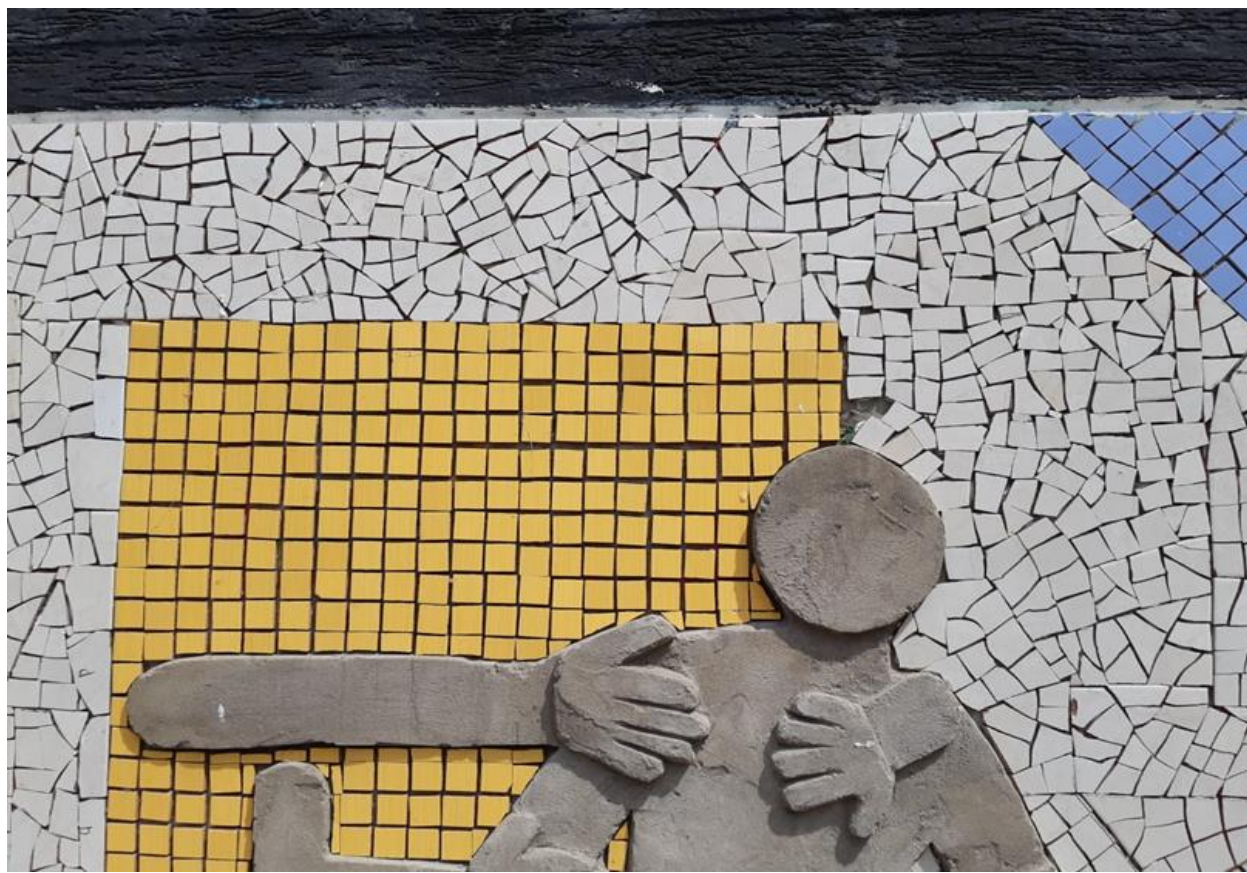
Fotografía 102 Pegado de mosaico beis del centro parte de arriba ya terminado
