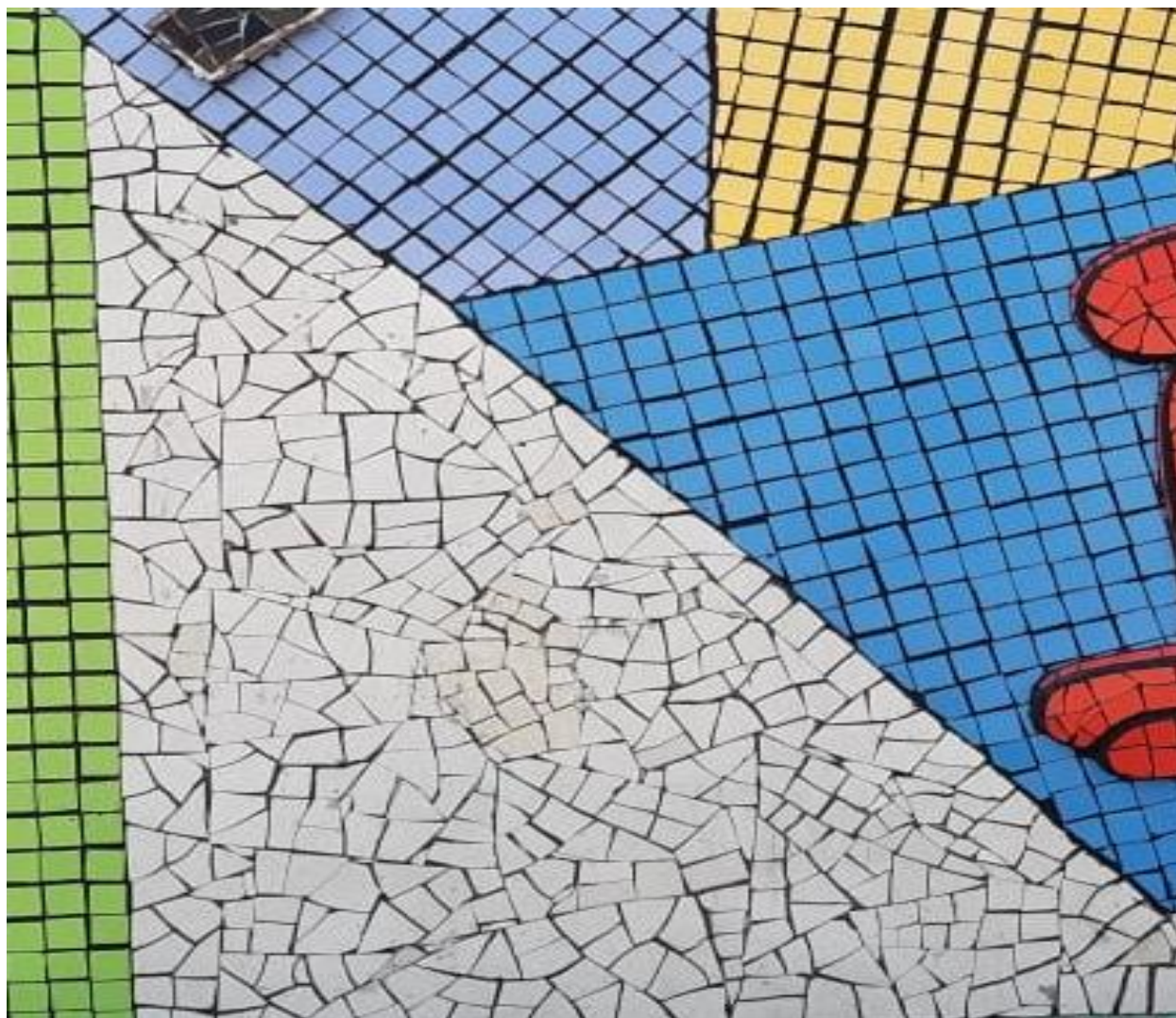
Fotografía 182 Lado derecho del mural fondo beis de las figuras ya emboquillado parte de abajo izquierda
