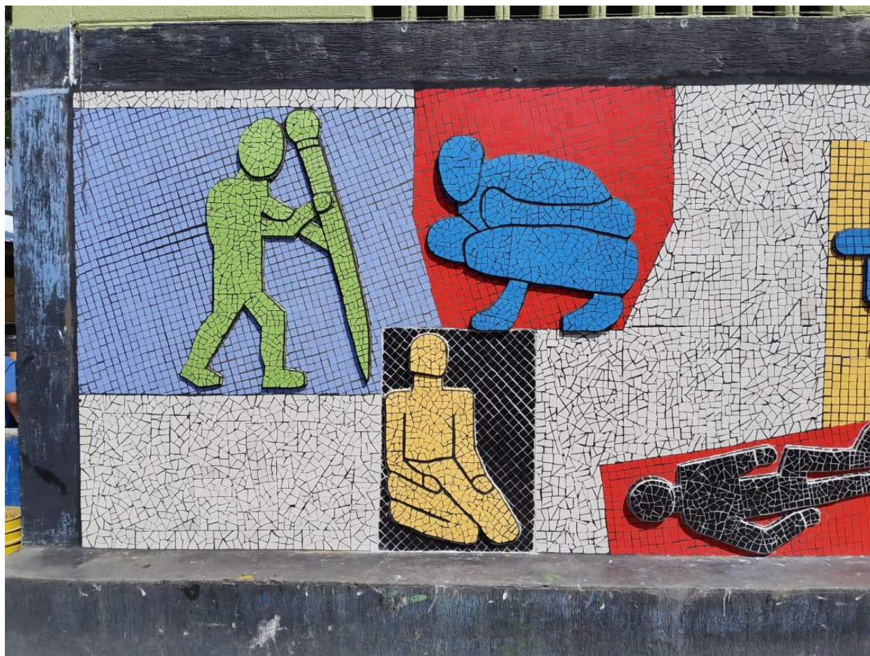
Fotografía 204 Lado izquierdo ya terminado con boquilla de las figuras, fondo de las figuras
