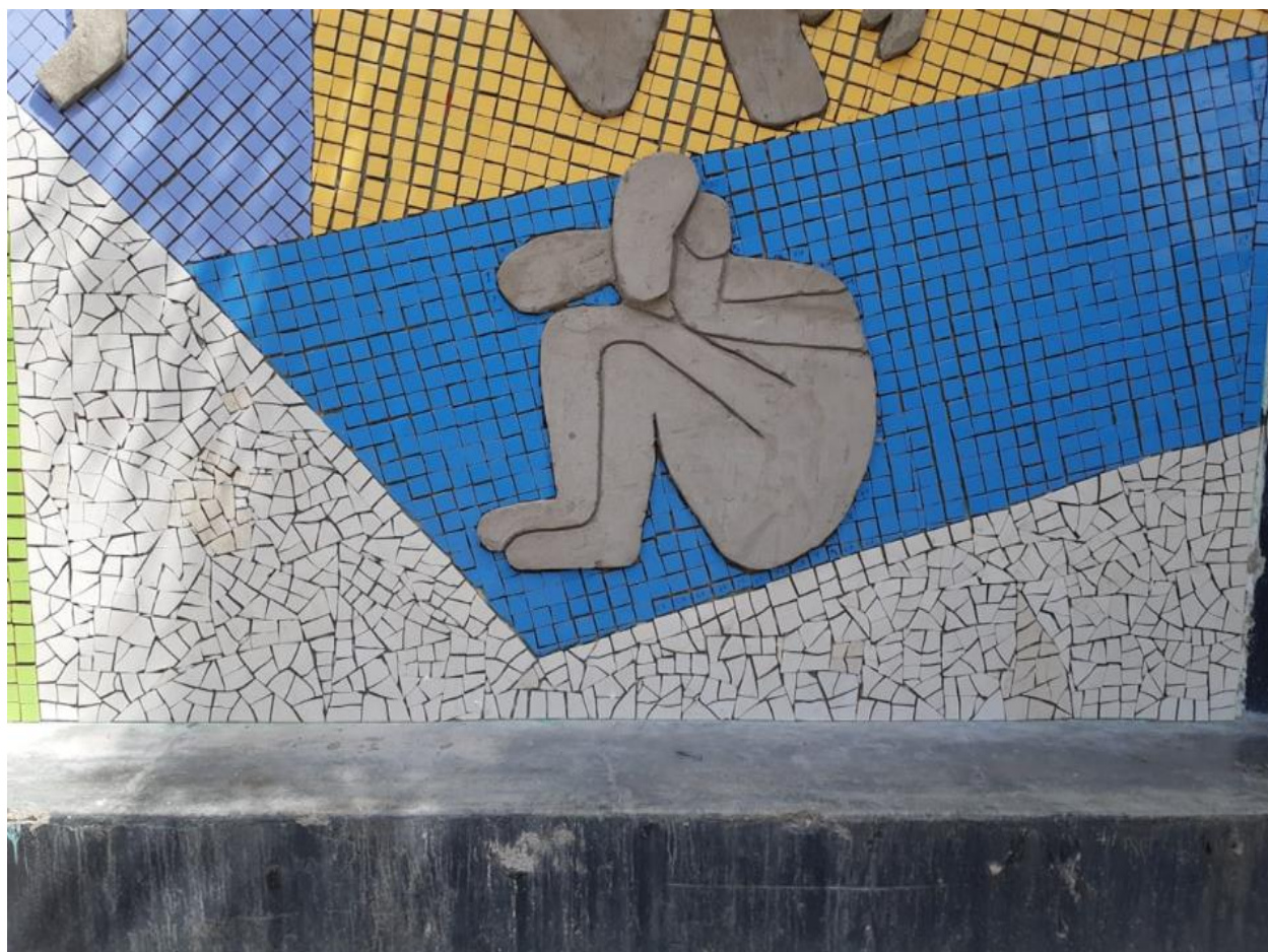
Fotografía 111 Pegado de mosaico beis del lado derecho parte de abajo ya terminado
