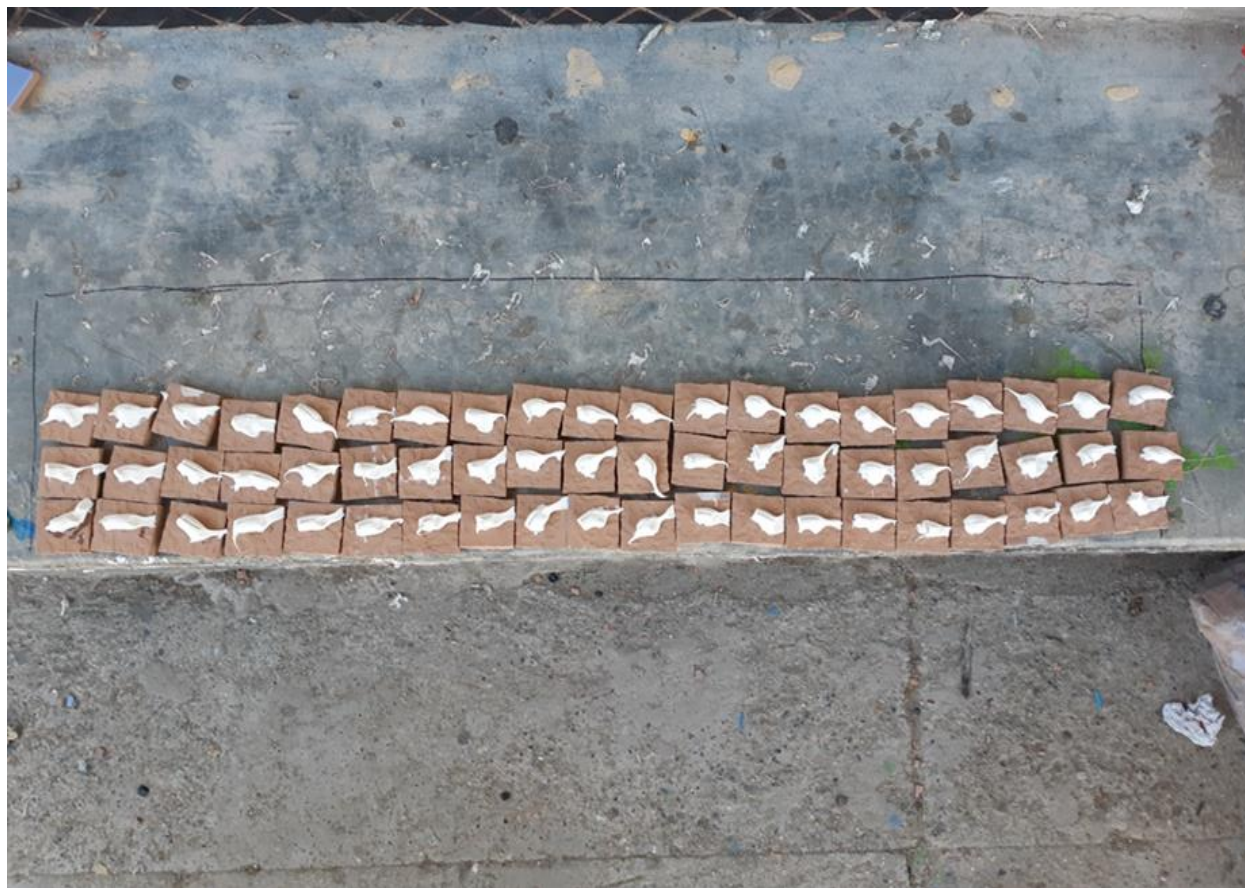
Fotografía 82 Teselas listas para pegar sobre la pared con silicona blanca americana de tubo
