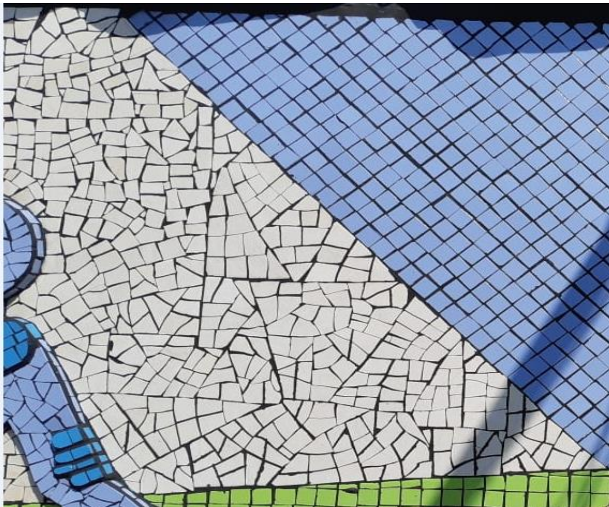
Fotografía 179 Centro del mural fondo beis de las figuras ya emboquillado parte derecha de arriba
