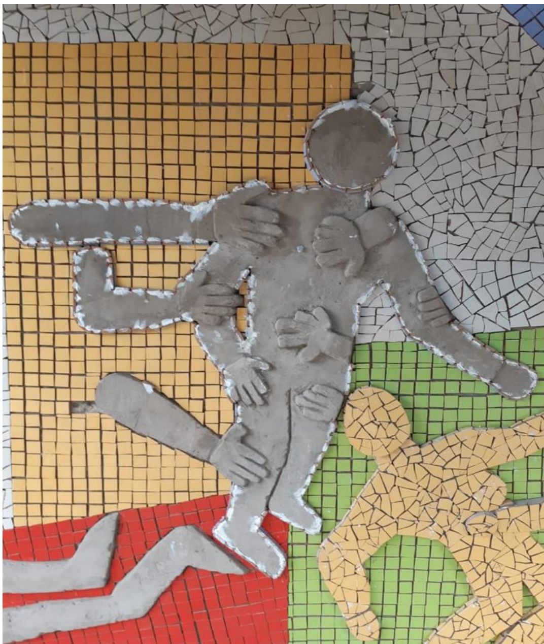
Fotografía 131 Figura centro ya terminada con su contorno externo en mosaico simétrico
