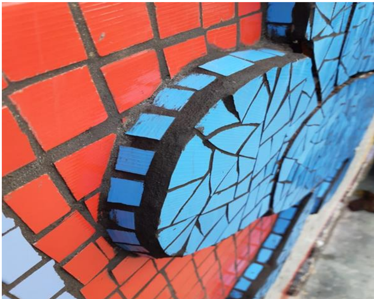
Fotografía 191 Emboquillado y limpieza de una las figura (violencia cuerpo) del lado izquierdo parte de arriba ya emboquillada contorno exterior de la pierna
