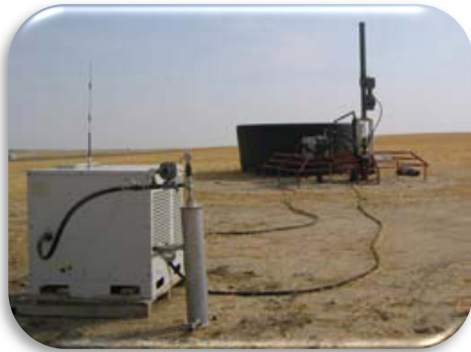
Figura 17. Bombeo Mecánico Lineal (Alimentación remota).
