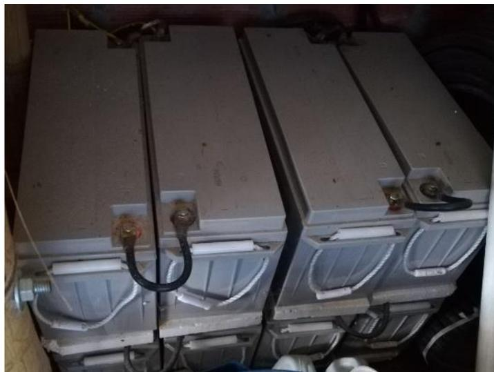
**Figura 10.** Banco de Baterías del sistema conectadas en serie
