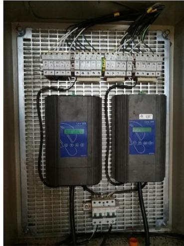
**Figura 9.** Reguladores de carga solar Leo20 implementados en la unidad
