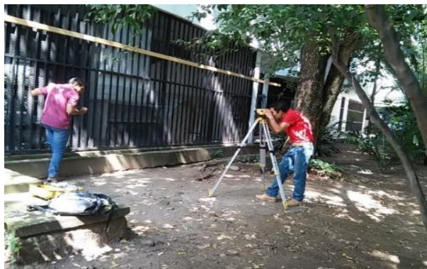
Figura 1. Trazado de línea de referencia en la reja mediante nivel óptico.
