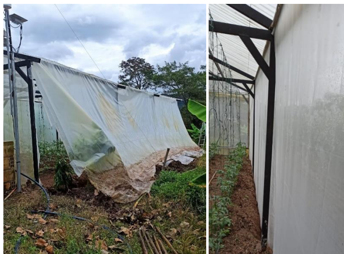
FIGURA 24. Extracción del plástico de la pared lateral, e instalación de malla anti-insectos.
