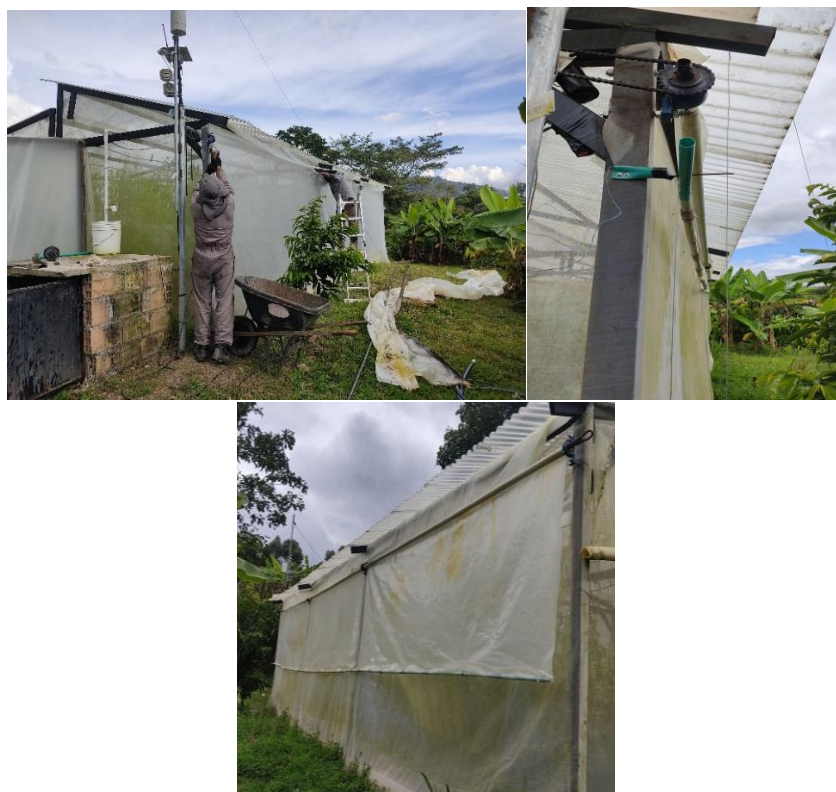
FIGURA 27. Cortina en funcionamiento con motor.
