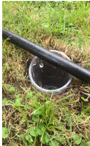
Anexo 9. Aforo lateral de riego.
