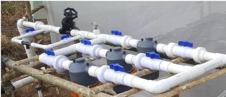
Figura 4. Componentes cabezal de riego
