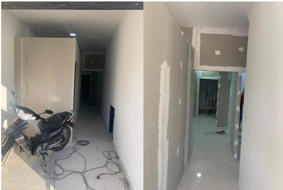
Figura 14. Adecuaciones nueva fábrica
