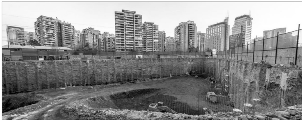
Figura 3-1. Ejemplo de excavación sobre pilotes realizada en grava de Santiago. Tomado de (Salas, 2018).
