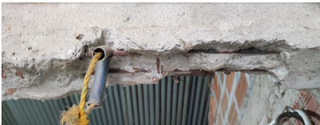
Figura 13. Evidencia de los detalles de columnas y vigas de confinamiento de la casa No. 13.
