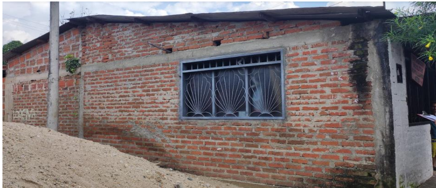
Figura 12. Evidencia de los muros confinados de la casa No. 13.
