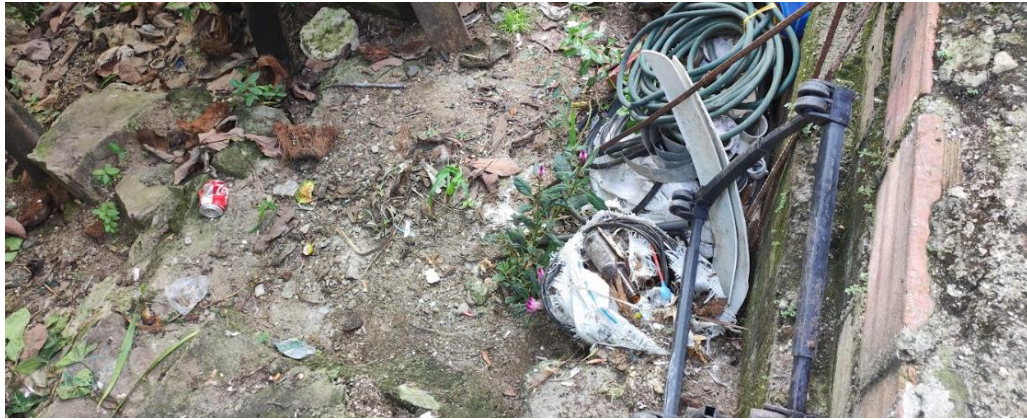
Figura 16. Evidencia del suelo de la casa No. 13.
