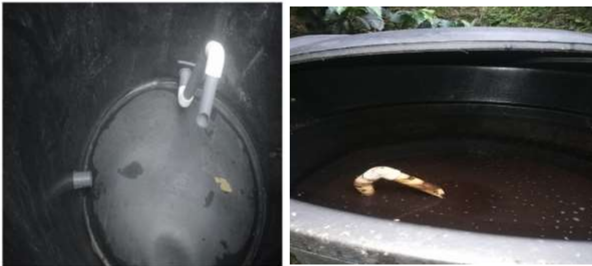
Figura 50. Reactores Hidrolítico Acidogénico.
