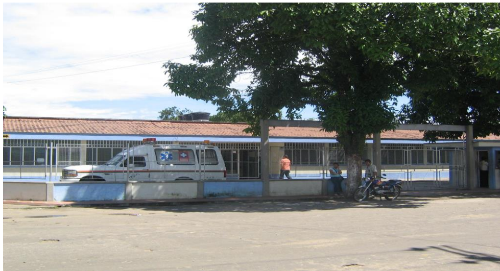
Fachada del hospital
