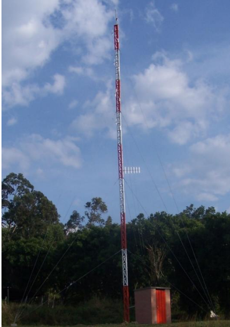
Torre Principal, caseta equipos.
