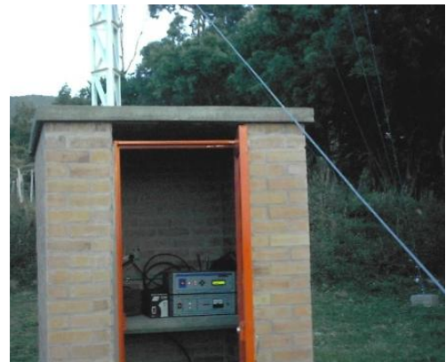
Cuarto de equipos. Foto. Cristhian Melo
