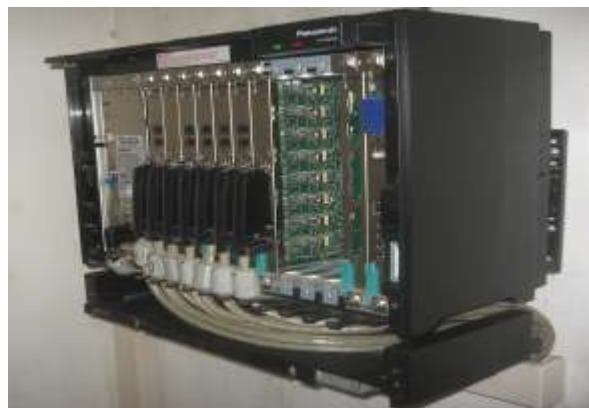
Figura 3 Planta PBX Panasonic KX-TDA200 – Sede Postgrados
