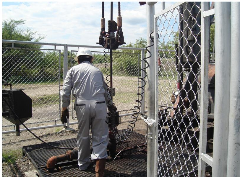
Figura 19. Instalación celda de carga
