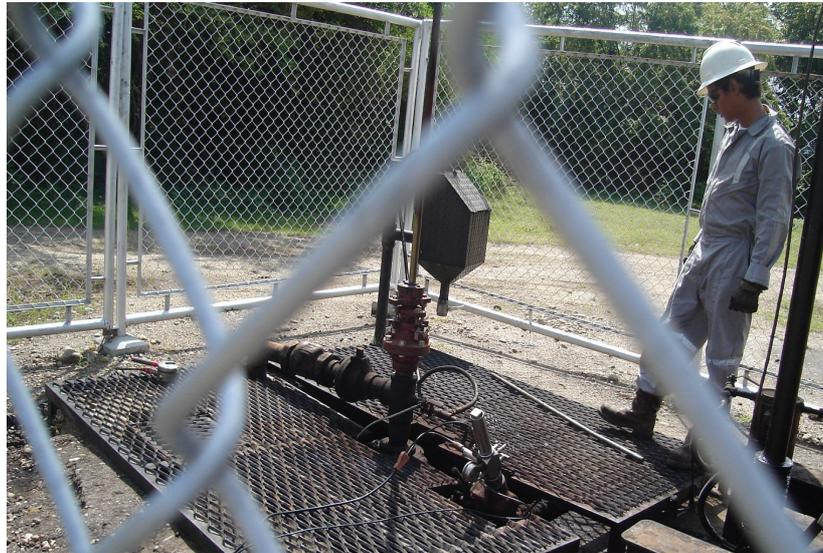
Figura 16. Instalación pistola para prueba de nivel
