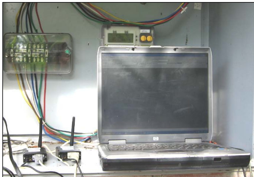
Fig. 69 Lectura medidor Elster A1800 municipio Guacirco
