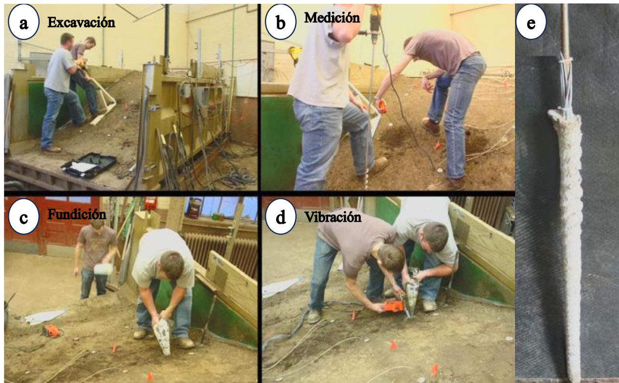
Figura 2: Fotografía de la construcción del sistema de contención para el modelo físico.
