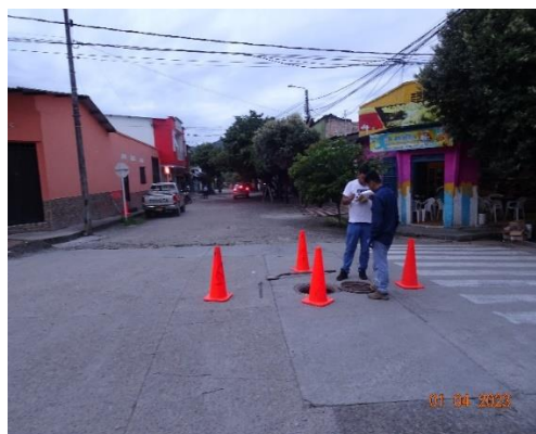
Figura 8 Registro fotográfico Carrera 8 entre calle 7 y 8
