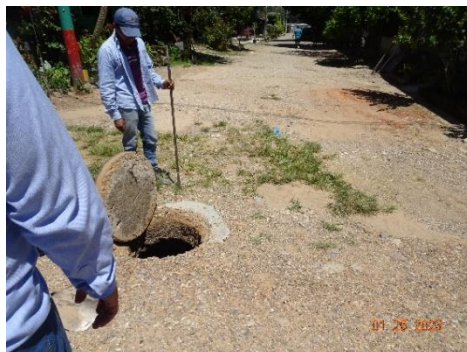
Figura 11 Carrera 10 entre calle 1 y zanjón
