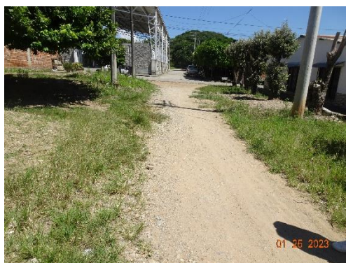
Figura 13 Carrera 12 entre calle 1 y 1ª
