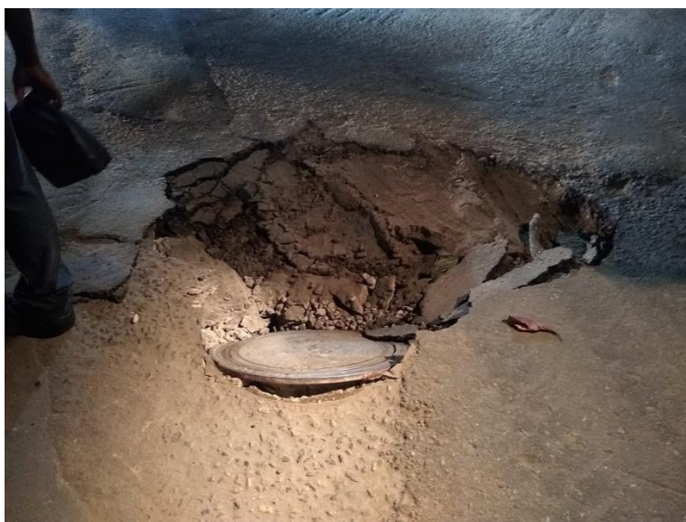
Daños ocasionados en las vías y viviendas aledañas por la maquinaria por falta de cuidado de los operadores (Avenida 26).
