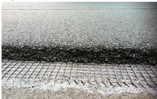
Figura 3-7 Geosintético con mezcla asfáltica.
