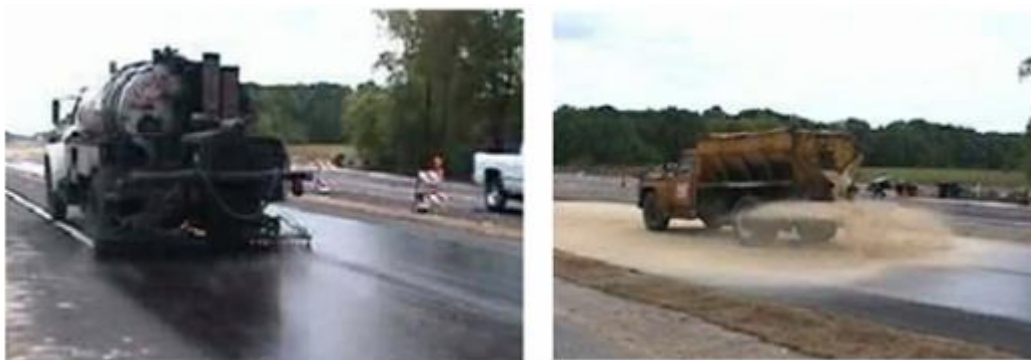
Figura 3-3 y Figura 3-4 Sello de arena - Ligante asfáltico.
