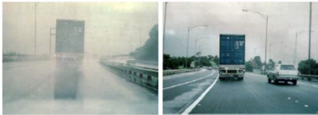
Figura 3-4 y Figura 3-5 comparación de la mejora en la visibilidad y desagüe en un pavimento asfáltico y una mezcla drenante.
