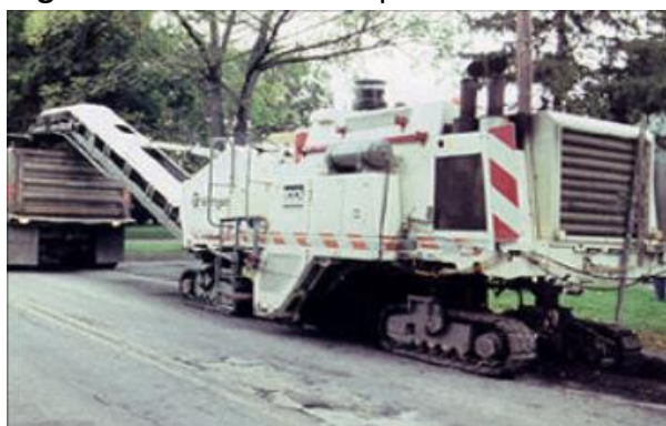
Figura 3-2 Fresado de un pavimento asfáltico.
