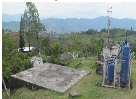
Desarenador del acueducto del casco urbano del municipio de Salado blanco
