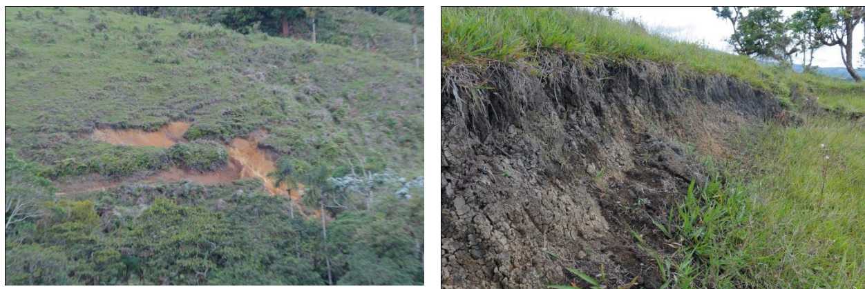
Procesos de erosión y deslizamiento en la cuenca alta Quebrada Guayabito
