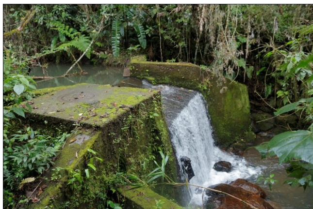
Bocatoma del acueducto del casco urbano del municipio de Salado blanco
