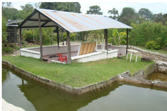
Foto 69. Estanques de agua. Bernardo Murcia. Finca Villa Stefany. Vereda Termopilas.
