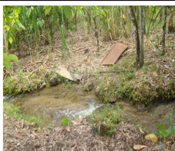
Foto 32. Canal de riego sin protección. Finca Vega El Puente, perteneciente a la Señora Maria Yolanda Castañeda, Vereda Termopilas.
