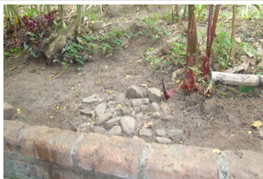
Foto 68. Filtro para aguas residuales del lavado de equipos. Finca La Giralda de la vereda Alto Guadual. Propiedad de la señora Yanira Plazas.
