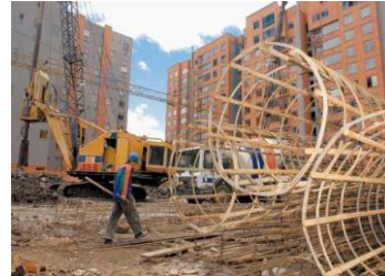
Ilustración 29. Construcción de vivienda.
