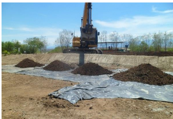
Fotografía 5. Montaje de biopilas con retroexcavadora Fuente: Archivo fotográfico de la planta Palmarito 2013
