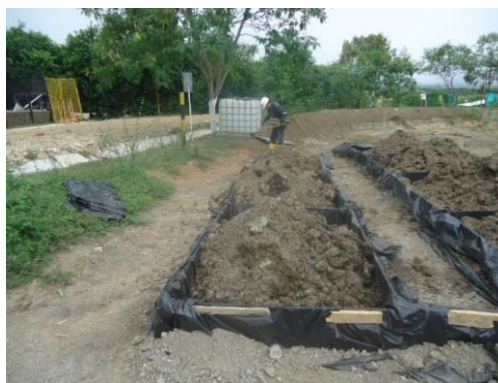
Fotografía 7. Biopilas en la terminación del montaje
