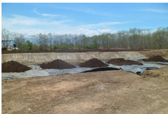
Fotografía 6. Montaje de biopilas Fuente: Archivo fotográfico de la planta Palmarito 2013
