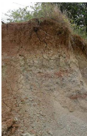
Fotografía 2. Erosión en Cárcavas geoformas de colinas en la Planta Palmarito Fuente: EIA Planta Palmarito – ATP INGENIERIA SAS
