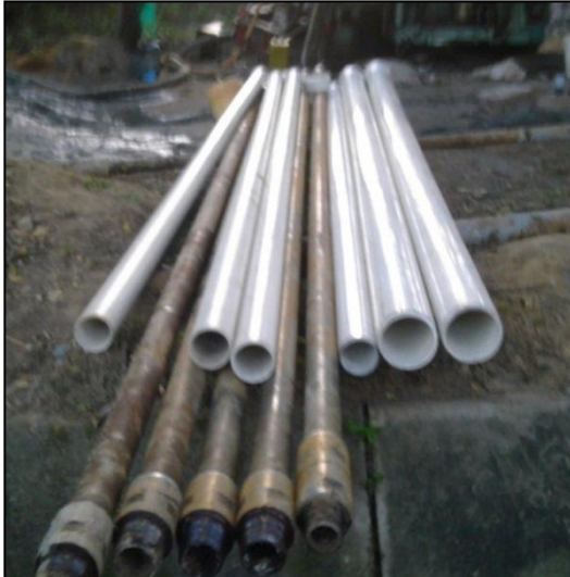
Fotografía 8. Tubería para el pozo USCO-1
