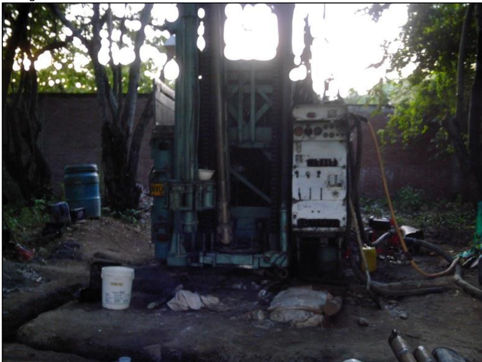
Fotografía 10. Inicios de la Perforación
