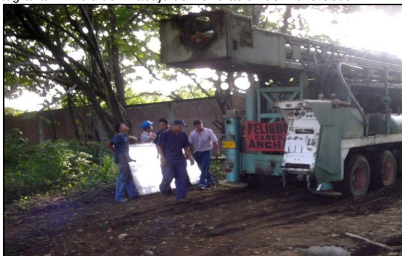
Fotografía 4. Inicio del Trabajo de Perforación del Pozo Usco-1
