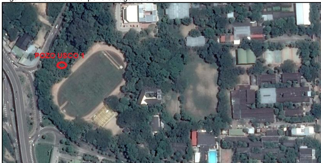
Figura 4. Ubicación del pozo de agua USCO-1
