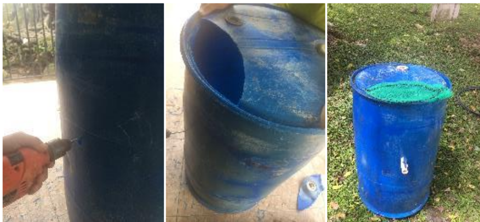
Figura 28. Construcción del Sedimentador Primario
