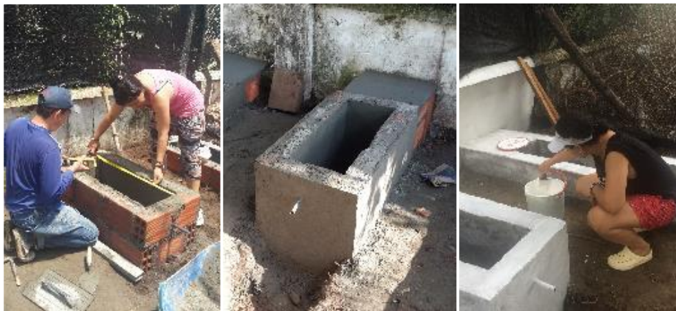
Figura 29. Construcción de los Canales de Fitorremediación
